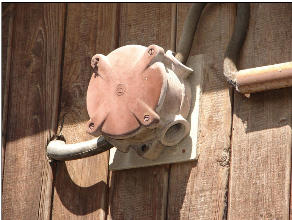
Foto 176: SO 03-55-01, stavební buňka, demolice č. 9; rozvodná krabice el. energie z foto 164 a 166, pod krabicí je deska na bázi cementu, deska na bázi cementu obsahuje azbestová vlákna
