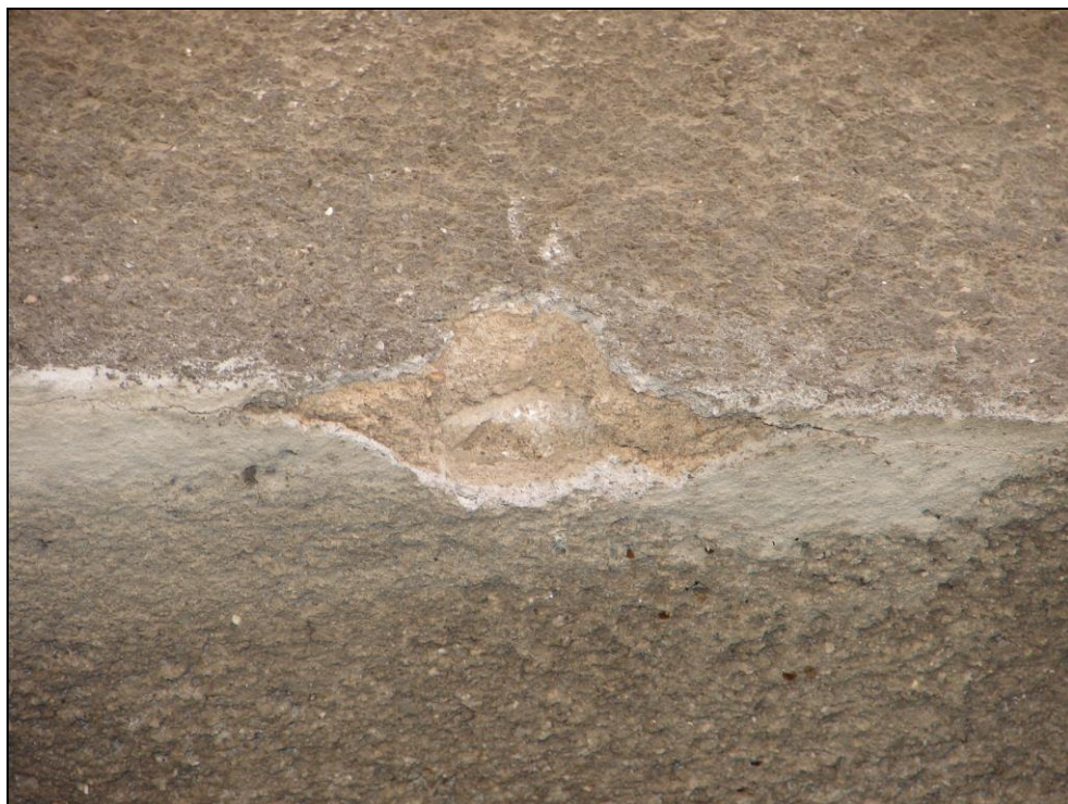
Foto 242: SO 03-55-01, trafostanice, fasáda směrem k trati; sonda pro zjištění materiálu nadpraží z foto 241, zjištěn beton
