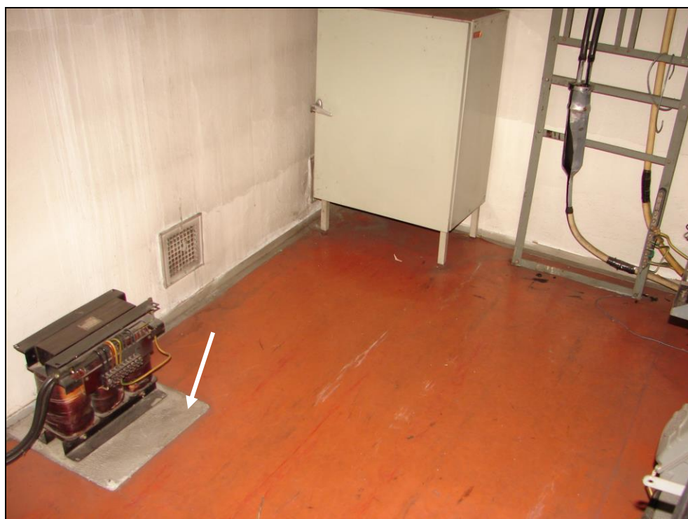
Foto 27 a 28: SO 02-55-01, hradlo Barrandov, interiér, zabezpečovací místnost; omítnuté zděné stěny a ŽB strop, na betonové podlaze PVC, pod malým transformátorem velmi pravděpodobně deska na bázi cementu - viz šipka, (dle nařízení pracovníka SŽDC nebylo s ohledem na BOZP možno blíže přistoupit), deska na bázi cementu obsahuje azbestová vlákna
