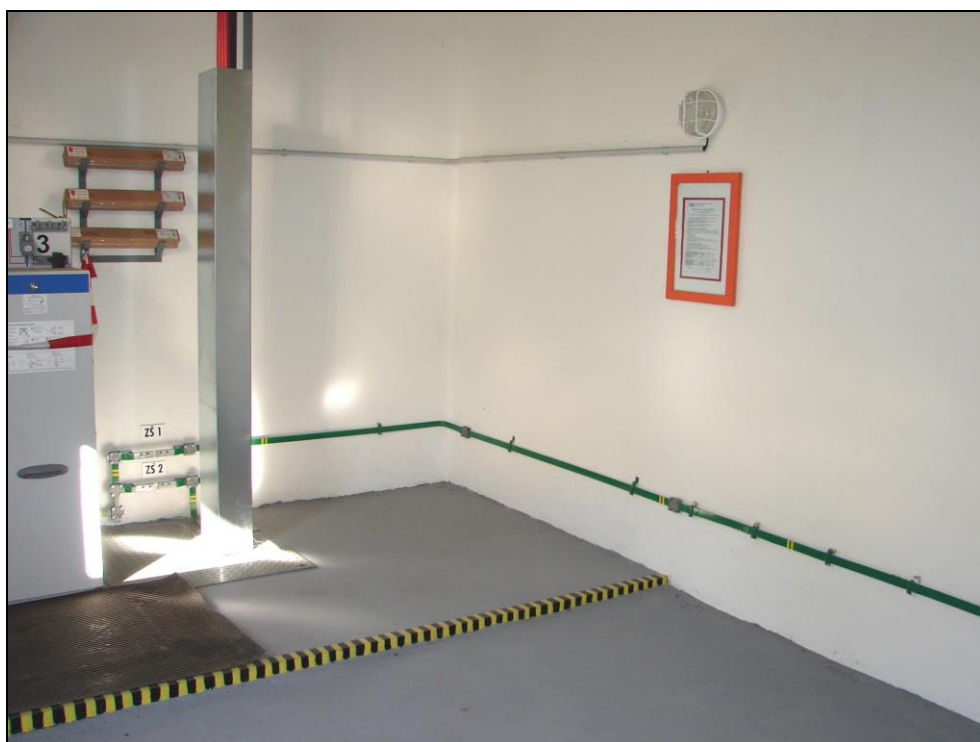
Foto 254 a 255: SO 03-55-01, trafostanice, interiér, rozvodna VN; omítnuté zděné stěny a ŽB strop, el. rozvody v plastových chráničcích, betonová podlaha opatřena stěrkou na bázi epoxidu, u technologického zařízení je na podlaze antistatická pryž
