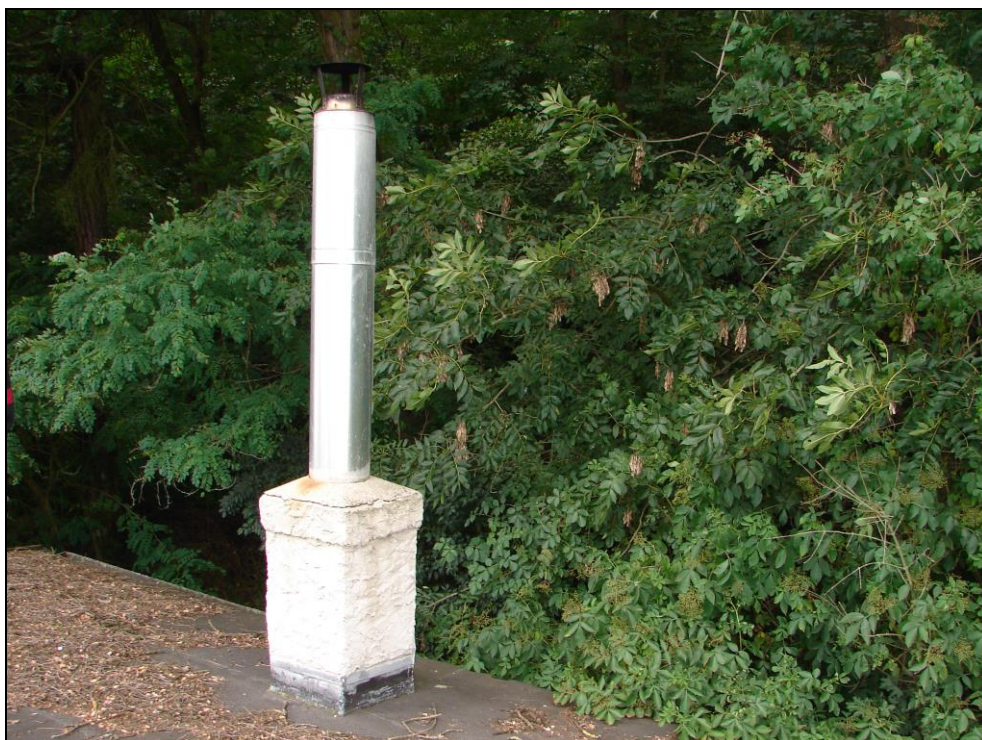
Foto 64: SO 02-55-01, hradlo závodiště, střecha; nerezový dvouplášťový komín
