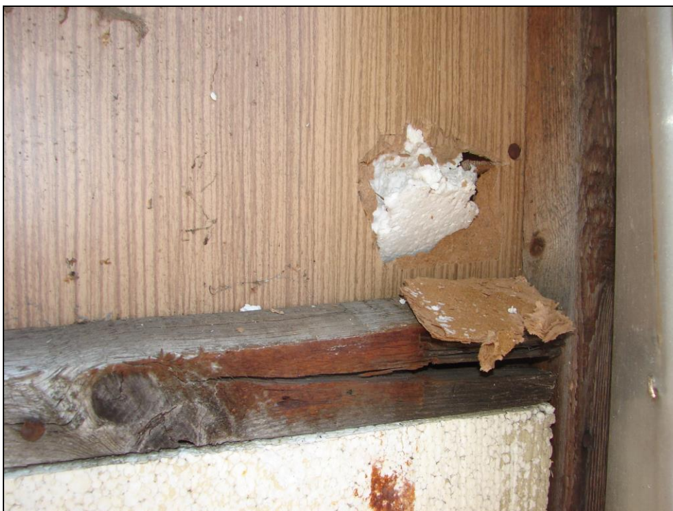
Foto 179: SO 03-55-01, stavební buňka, demolice č. 9; plechem je fixován na dřevěný rošt, patrný je i polystyren, skladba stěnového sendvičového panelu: sololit - polystyren - sololit
