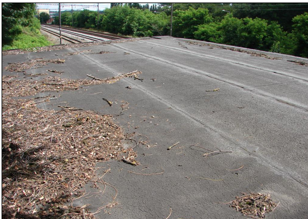
Foto 62: SO 02-55-01, hradlo závoďiště, střecha; střešní krytina ze 4 vrstev asfaltových lepenek prokládaných asfaltovým nátěrem, ze souvrství lepenek byl odebrán vzorek (foto 73), asfaltové lepenky neobsahují azbest jako plnivo
