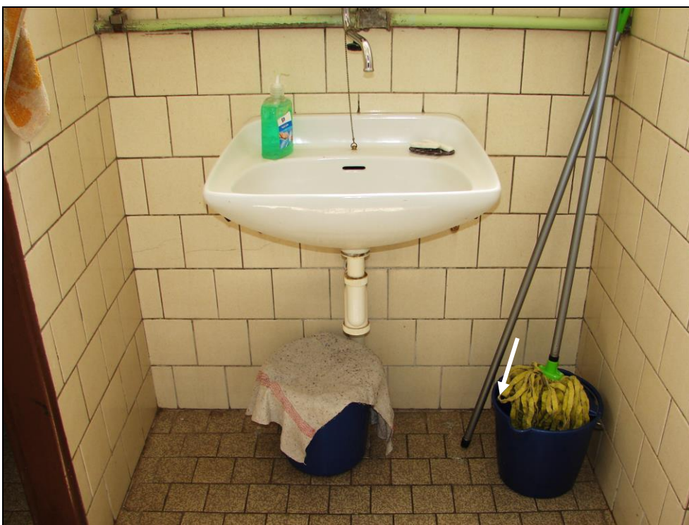
Foto 11 a 12: SO 02-55-01, hradlo Barrandov, interiér, soc. zařízení, umývárna; omítnuté zděné stěny a ŽB strop, keramický obklad stěn, kovové okno, na betonové podlaze keramická dlažba
