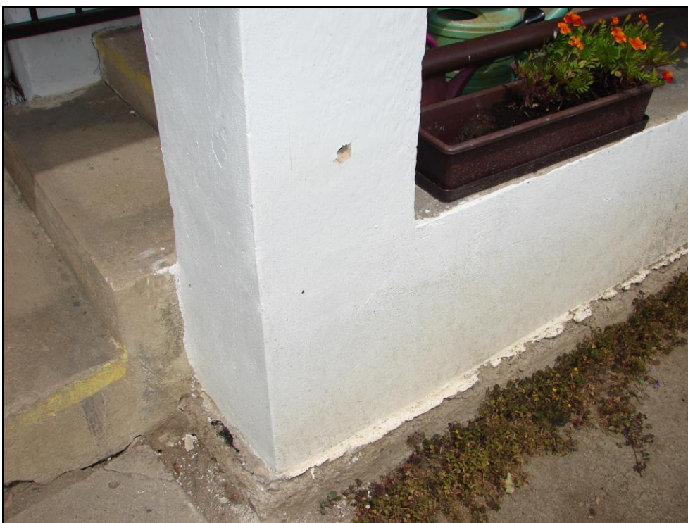
Foto 44: SO 02-55-01, hradlo závodiště; zděný pilíř (CP), zjištěno vrtem Ø 10 mm
