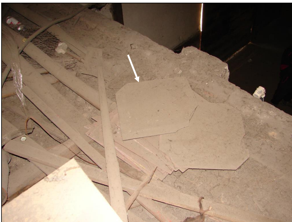
Foto 118: SO 03-55-01, sklad, interiér, půdní prostor v oblasti zděné štítové stěny; na pódiu před vstupem do půdního prostoru je několik střešních šablon na bázi cementu (šipka), střešní šablony na bázi cementu obsahují azbestová vlákna (podr. foto 119 - 121)
