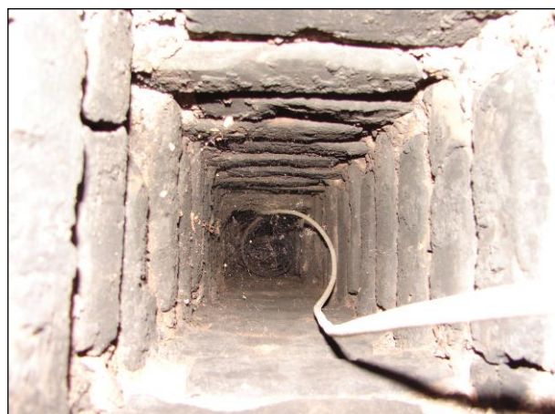
Foto 231 a 232: SO 03-55-01, domek TO, střecha; pohled do průduchů zděných komínů vlevo komín z foto 229, vpravo z foto 230
