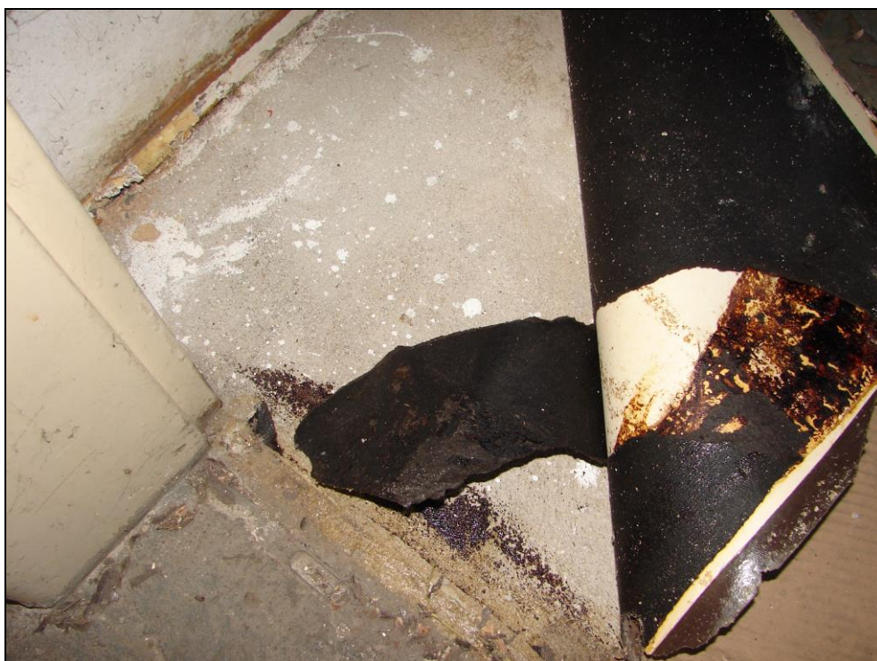
Foto 89: SO 03-55-01, sklad, interiér, předsíň; betonová podlaha, asfaltová lepenka pod PVC, z asfaltové lepenky byl odebrán vzorek (foto 135), asfaltová lepenka neobsahuje azbest jako plnivo
