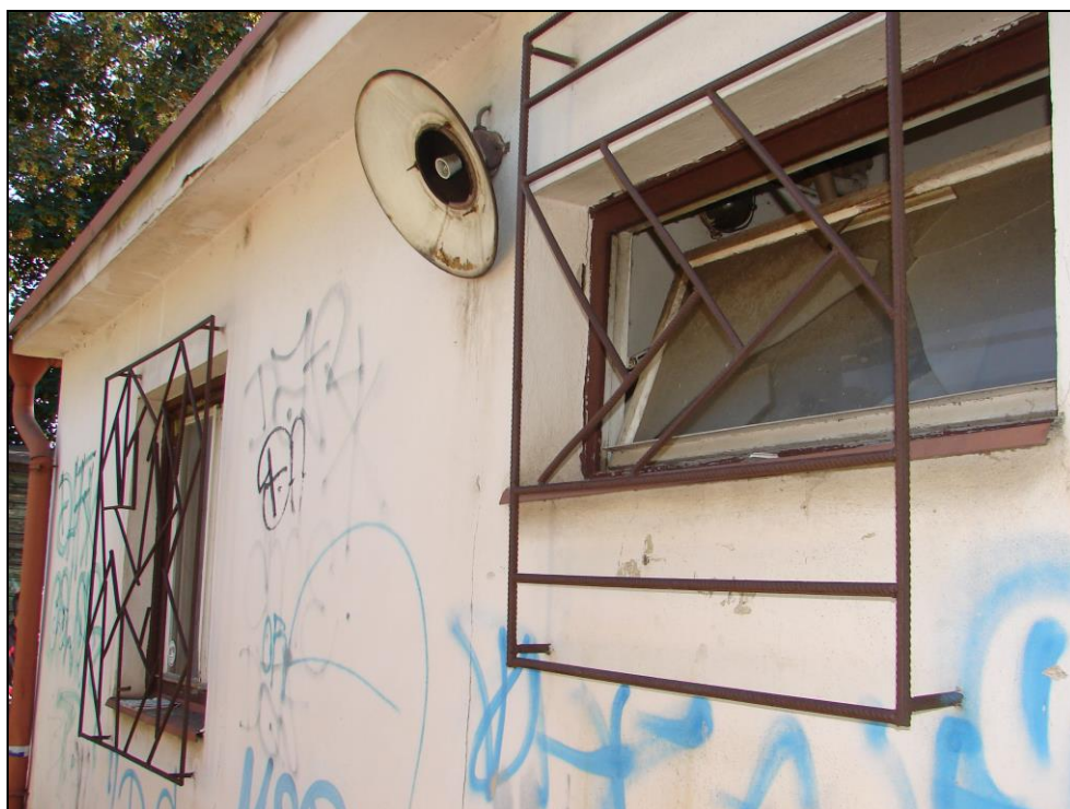
Foto 198: SO 03-55-01, domek TO, fasáda domku odvrácená od trati; omítnutá montovaná panelová konstrukce (foto 201 a 202), dřevěná okna
