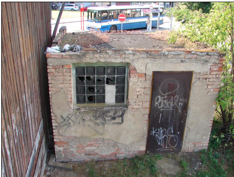
Foto 136: SO 03-55-01, zděný přístavek u skladu; celkový pohled, železobetonový strop (střecha) bez krytiny, zděné stěny (CP), okno z luxferů
