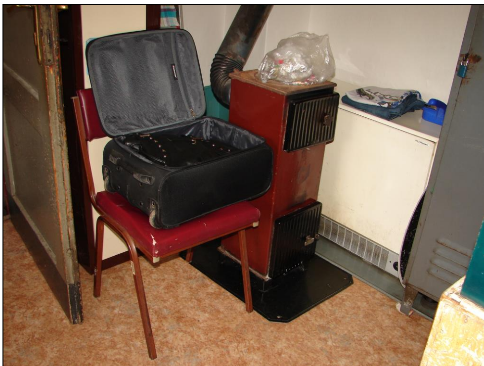
Foto 49 a 50: SO 02-55-01, hradlo závodíště, interiér, hlavní místnost; omítnuté zděné stěny a dřevěný strop, dřevěné dveře, na dřevěné podlaze PVC (foto 53), plechy pod kamny bez ohnivzdorného materiálu na spodní straně (foto 54)
