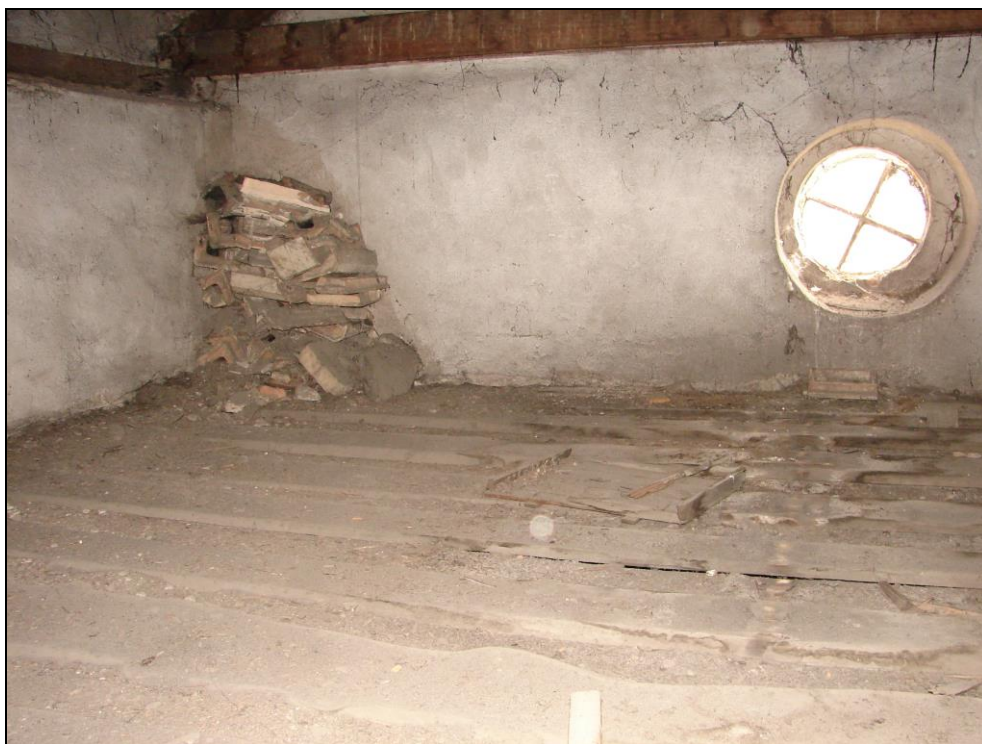
Foto 115 a 116: SO 03-55-01, sklad, interiér, půdní prostor v oblasti zděné štítové stěny (foto 75); zděné omítnuté stěny, dřevěný krov, dřevěné okno, dřevěná podlaha, v rohu fragmenty kachlových kamen
