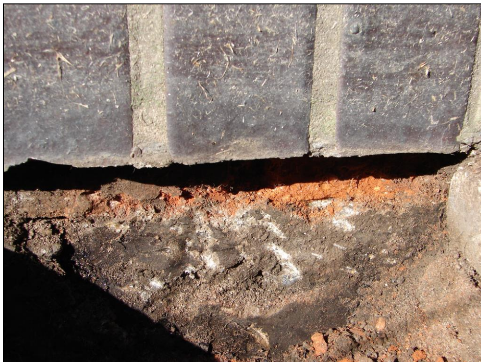
Foto 244: SO 03-55-01, trafostanice; sonda pro zjištění materiálu stěn a základů, stěny jsou vyzděné z plných cihel (CP), základy tvoří betonové pásy, sokl opatřen keramickým obkladem
