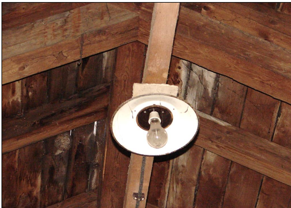
Foto 107: SO 03-55-01, sklad, interiér, hlavní skladovací prostor; deska na bázi cementu pod osvětlením z foto 99 a 101, z desky na bázi cementu byl odebrán vzorek (foto 131), deska na bázi cementu obsahuje azbestová vlákna
