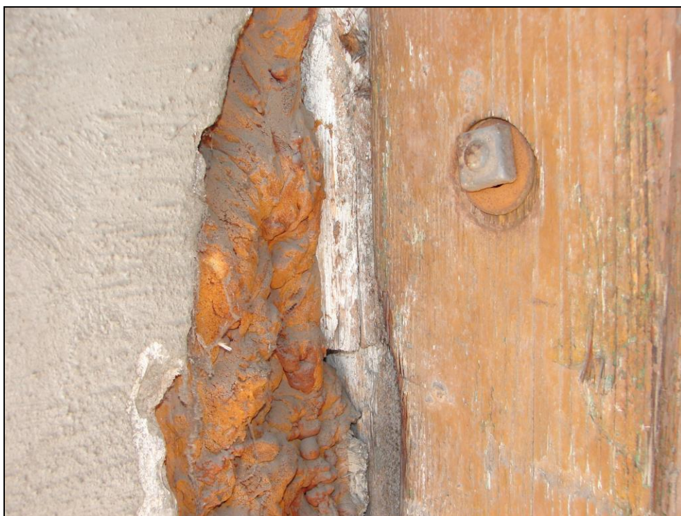
Foto 84: SO 03-55-01, sklad; dřevěná vrata z foto 83, těsnění PUR pěnou
