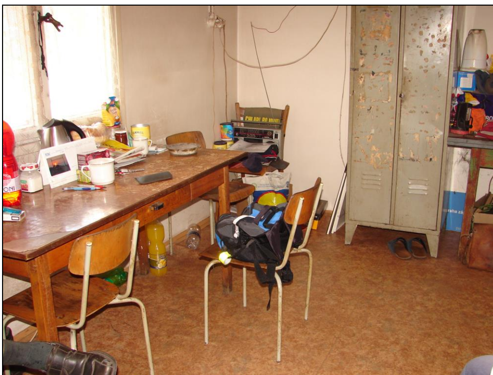
Foto 206 a 207: SO 03-55-01, domek TO, interiér, místnost 1 (foto 203); omítnutý strop a stěny z panelů, el. rozvody na kovových lištách, dřevěné okno, na betonové podlaze PVC
