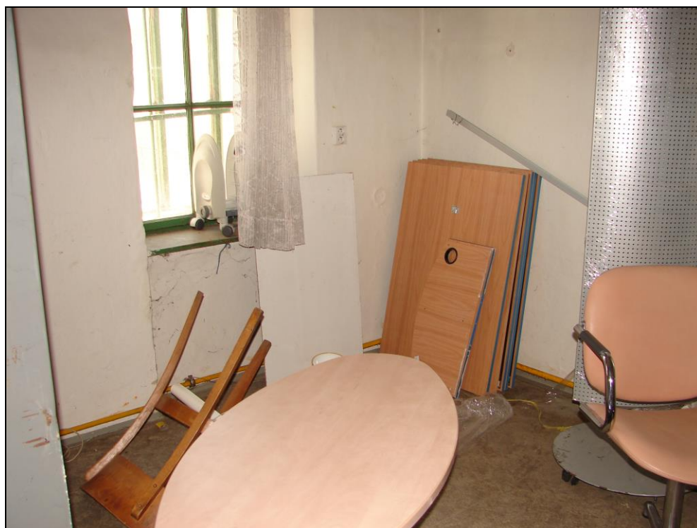
Foto 93 a 94: SO 03-55-01, sklad, interiér, místnost po vstupu z předsíně (rohová); omítnuté zděné stěny a dřevěný strop, dřevěné okno, na betonové podlaze PVC
