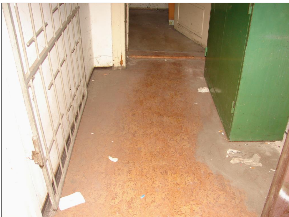
Foto 87 a 88: SO 03-55-01, sklad, interiér, předsiň; omítnuté zděné stěny a dřevěný strop, na betonové podlaze PVC (foto 89), ocelová mříž, vstup do místnosti před hlavním skladovacím prostorem
