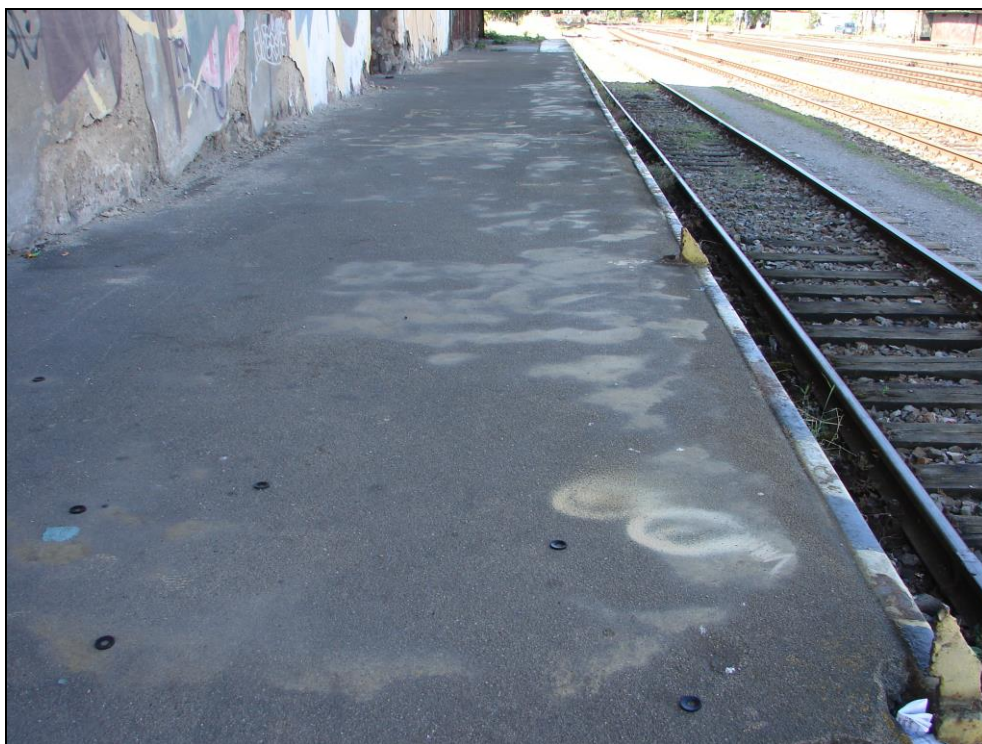
Foto 126: SO 03-55-01, sklad, rampy; rampa podél trati, na hraně rampy kolejnice, povrch beton, u dřevěné části skladu částečně kamenná dlažba (foto 127)
