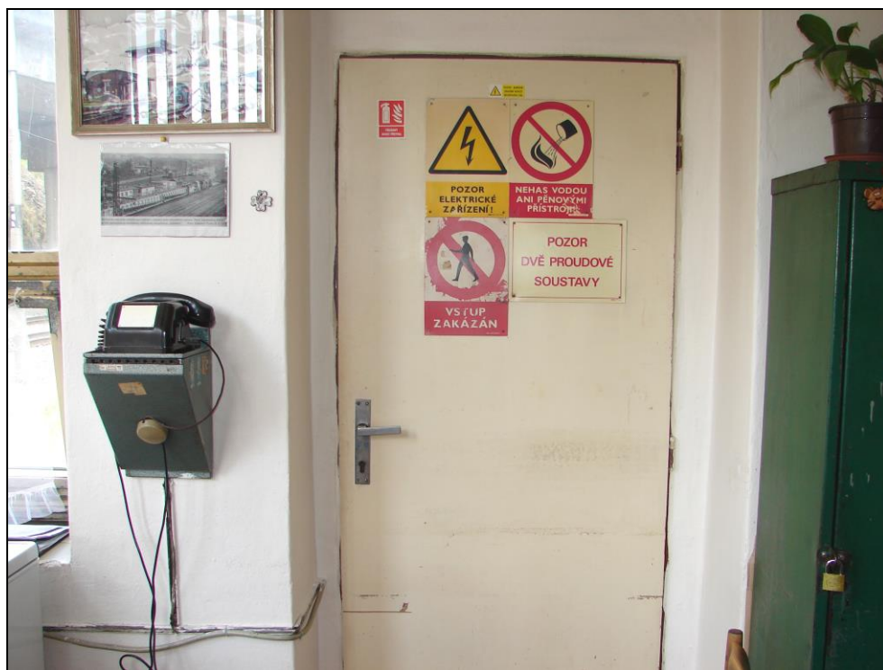
Foto 24: SO 02-55-01, hradlo Barrandov, interiér, hlavní místnost; omítnuté zděné stěny a ŽB strop, kovové okno, vstup do zabezpečovací místnosti
