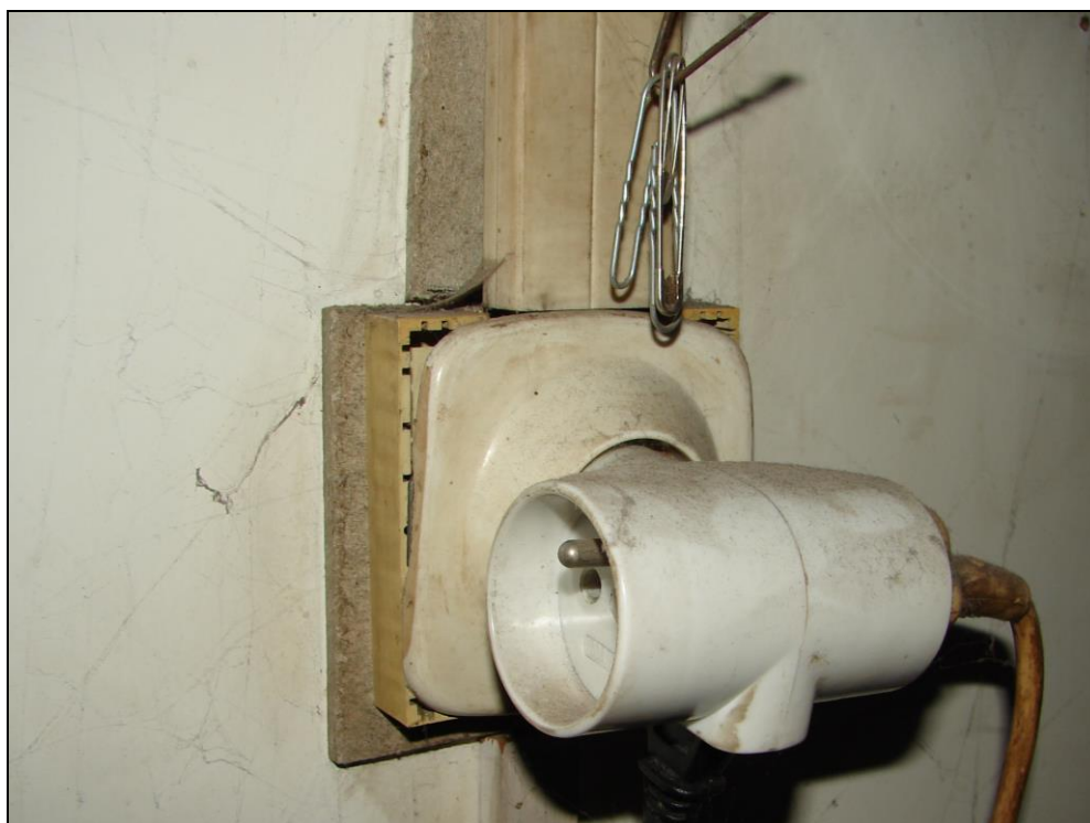
Foto 168: SO 03-55-01, stavební buňka, demolice č. 8, interiér; pod plastovými lištami s el. rozvody a zásuvkou jsou desky na bázi cementu, desky na bázi cementu obsahují azbestová vlákna
