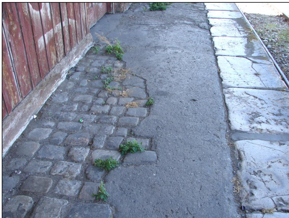
Foto 127: SO 03-55-01, sklad, rampy; rampa podél trati u dřevěné části skladu, na hraně rampy kolejnice, povrch částečně beton a částečně kamenná dlažba
