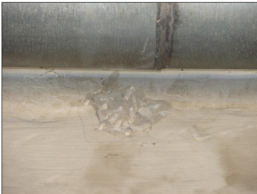
Foto 243: SO 03-55-01, trafostanice, fasáda směrem k trati; sonda pro zjištění materiálu římsy, zjištěn beton (sonda provedena cca nad sondou do nadpraží na foto 241)
