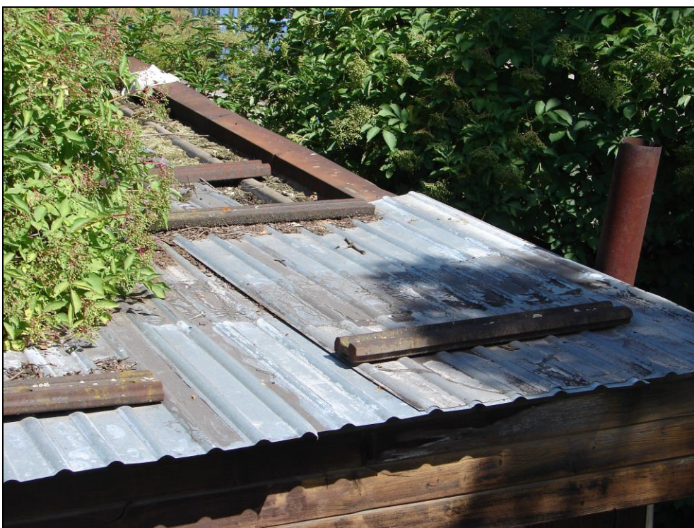
Foto 151: SO 03-55-01, stavební buňka, demolice č. 7, střecha; pohled na buňku, střešní krytina z trapézového plechu částečně překrytá dalším trapézovým plechem (foto 148) zatíženým kolejnicemi
