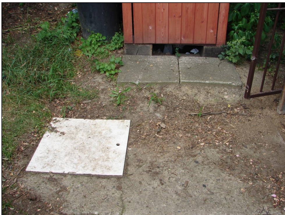
Foto 68: SO 02-55-01, hradlo závodiště, platový poklop jímky na fekálie z dřevěného suchého WC
