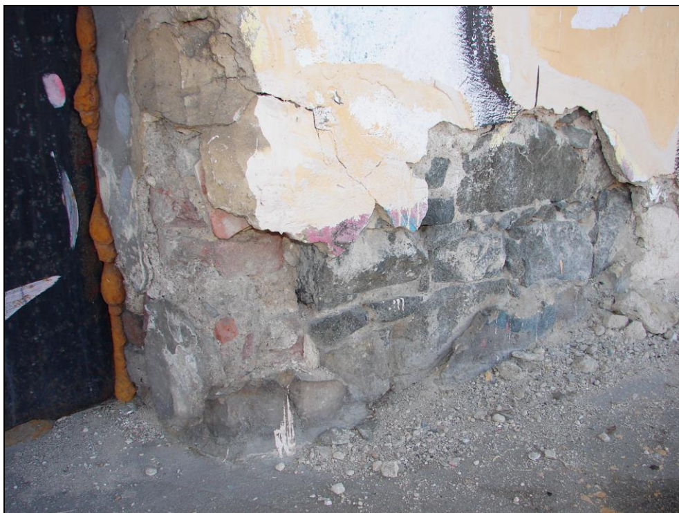
Foto 79: SO 03-55-01, sklad; obvodové kamenné zdivo s podílem cihel (CP), obvodová stěna směrem k trati
