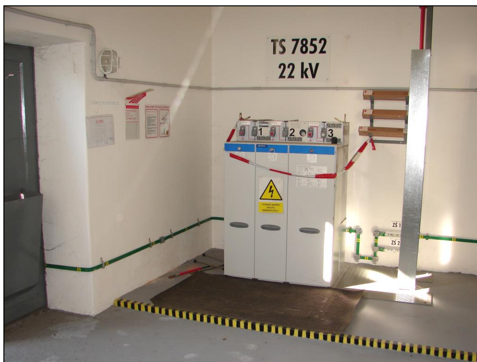
Foto 252 a 253: SO 03-55-01, trafostanice, interiér, rozvodna VN; omítnuté zděné stěny a ŽB strop, prosklení z luxferů (foto 238), kovová vrata, el. rozvody v plastových chráničkách, betonová podlaha opatřena stěrkou na bázi epoxidu, u technologického zařízení je na podlaze antistatická pryž
