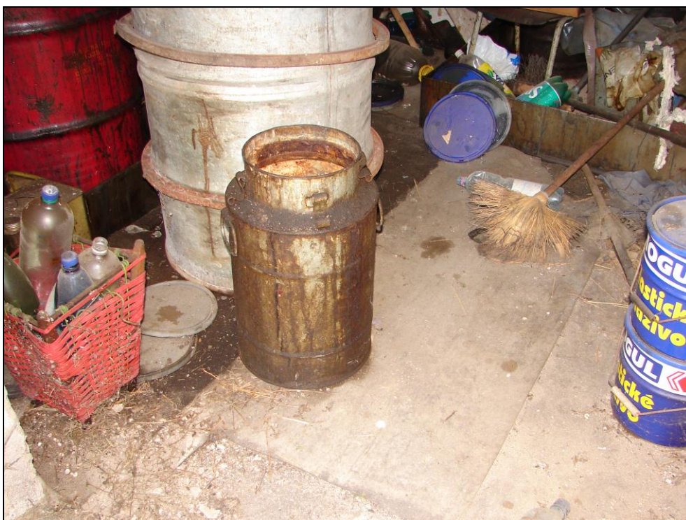
Foto 138 a 139: SO 03-55-01, zděný přístavek u skladu, interiér; železobetonový strop (střecha), zděné stěny (CP), na betonové podlaze PVC, v přístavku je sklad olejových produktů, oleje jsou v nádobách či sudech, sudy jsou zpravidla postaveny v plechových vanách (foto 140 a 141), povrch PVC je místy od oleje, zasažení betonové podlahy olejem je povrchové, lokální, minimálního rozsahu a zcela zanedbatelné
