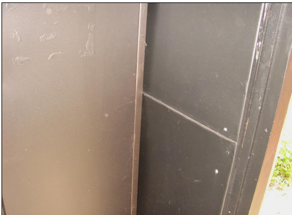
Foto 157: SO 03-55-01, stavební buňka, demolice č. 7, interiér; stěny rohu vlevo u vstupu a části stropu (místo pro kamna) jsou opatřeny plechy s ohnivzdorným materiálem na bázi cementu na rubové straně (foto 192 a 193), materiál na bázi cementu na rubové straně plechu obsahuje azbestová vlákna
