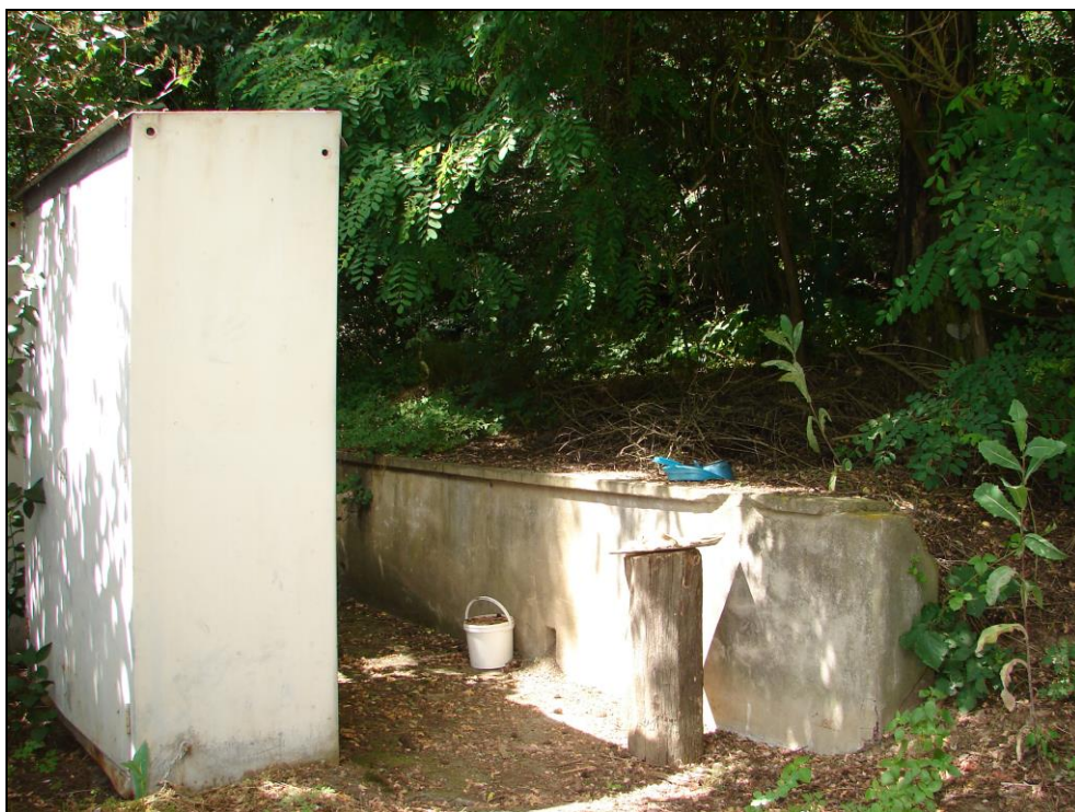
Foto 72: SO 02-55-01, hradlo závodisti, okolí hradla; omítnutá zděná opěrná stěna, kovová rozvodná skříň (nepřístupná)
