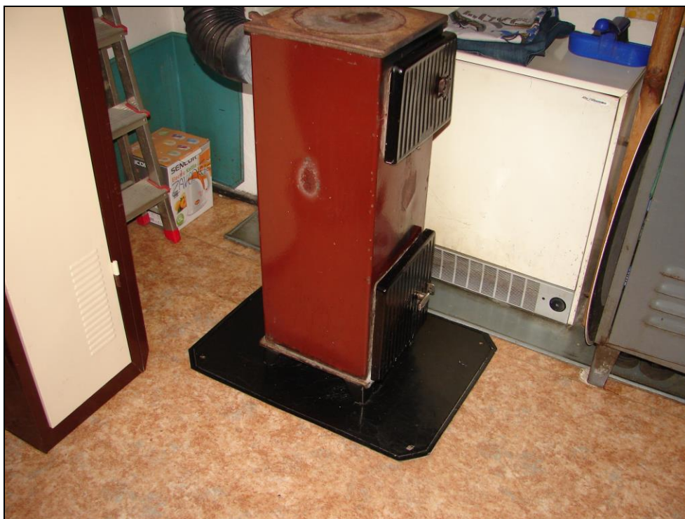
Foto 54: SO 02-55-01, hradlo závoďiště, interiér, hlavní místnost; plech pod kamny na tuhá paliva, pod akumulacími kamny i plech v rohu místnosti bez ohnivzdorného materiálu na spodní straně
