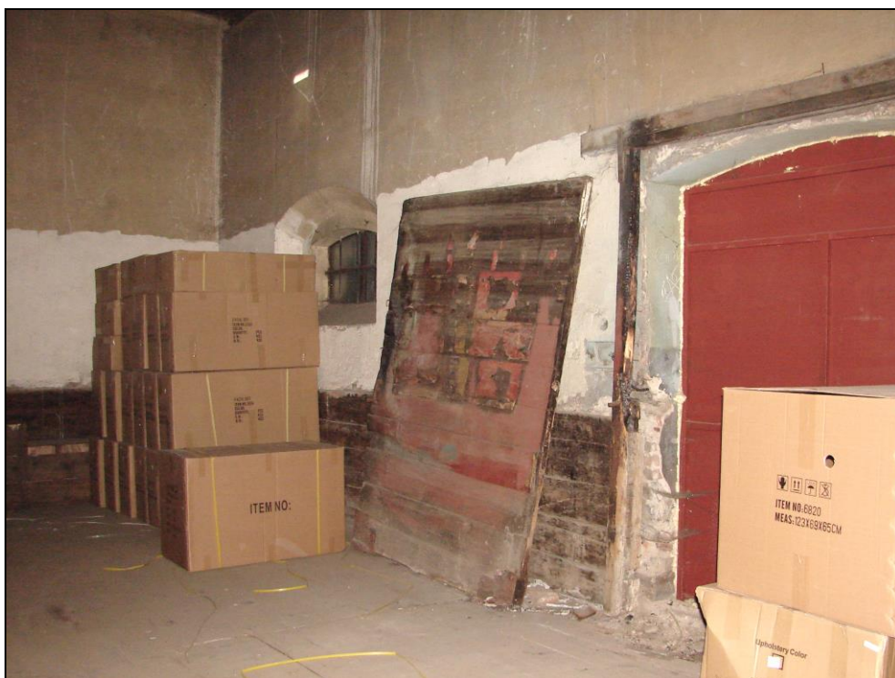
Foto 101 a 102: SO 03-55-01, sklad, interiér, hlavní skladovací prostor; omítnuté zděné stěny, dřevěný krov, dřevěná podlaha (foto 103), šipkou je vyznačena deska na bázi cementu pod osvětlením z foto 99 (podrobně foto 107)
