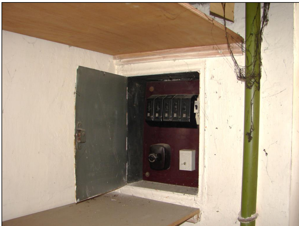
Foto 91: SO 03-55-01, sklad, interiér, předsíň; omítnuté zděné stěny, el. rozvody v plechové skříni podložené deskou z pertinaxu, zelená ocelová chránička
