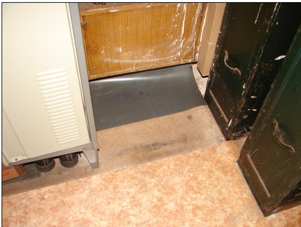
Foto 53: SO 02-55-01, hradlo závoďiště, interiér, hlavní místnost; podlaha dřevotřískové desky na fošnách, krytina PVC
