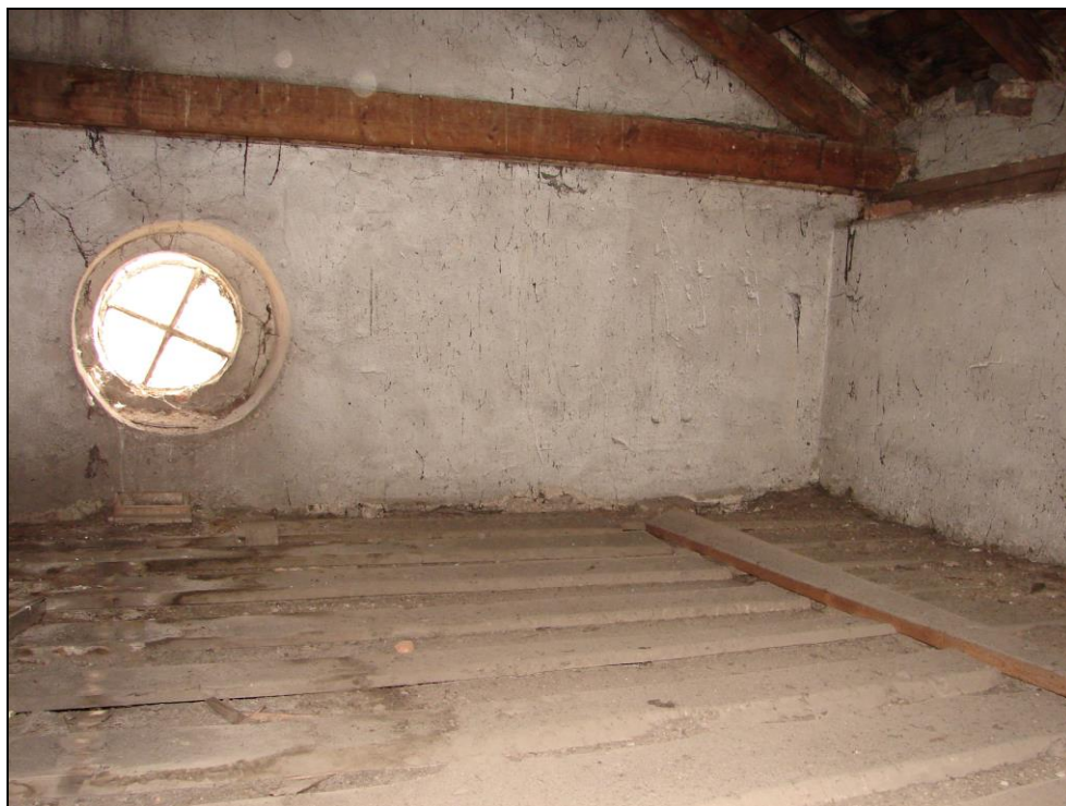
Foto 117: SO 03-55-01, sklad, interiér, půdní prostor v oblasti zděné štítové stěny (foto 75); zděné omítnuté stěny, dřevěný krov, okno i podlaha
