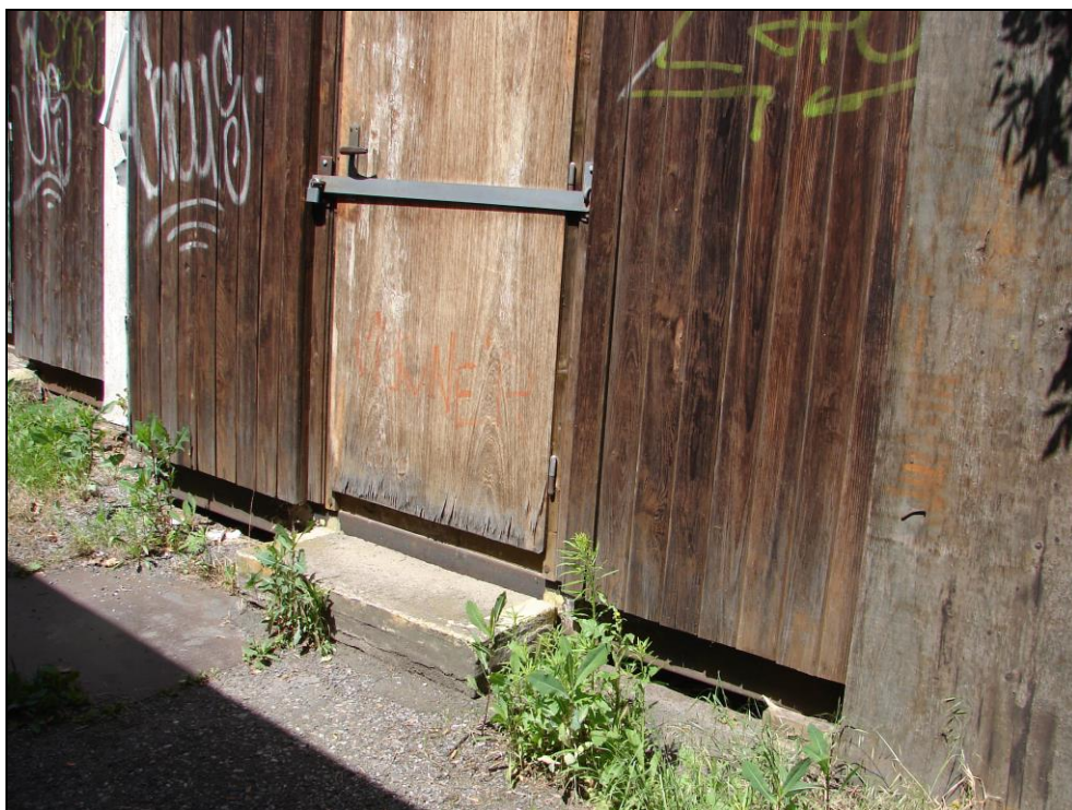
Foto 160 a 161: SO 03-55-01, stavební buňka, demolice č. 8; pohled na buňku, sendvičové stěnové panely (foto 178 a 179) jsou částečně pobity palubkami a částečně plechem, betonový schod, šipkou vyznačena rozvodná krabice el. energie (foto 162)
