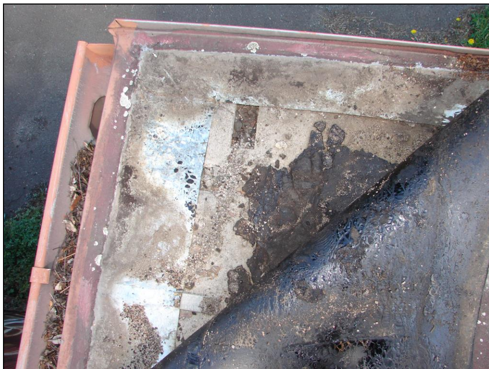
Foto 233: SO 03-55-01, domek TO, střecha; pod střešní krytinou ze souvrství asfaltových lepenek pojených litým asfaltem (foto 229 a 230), je patrná betonová konstrukce střechy (stropu)
