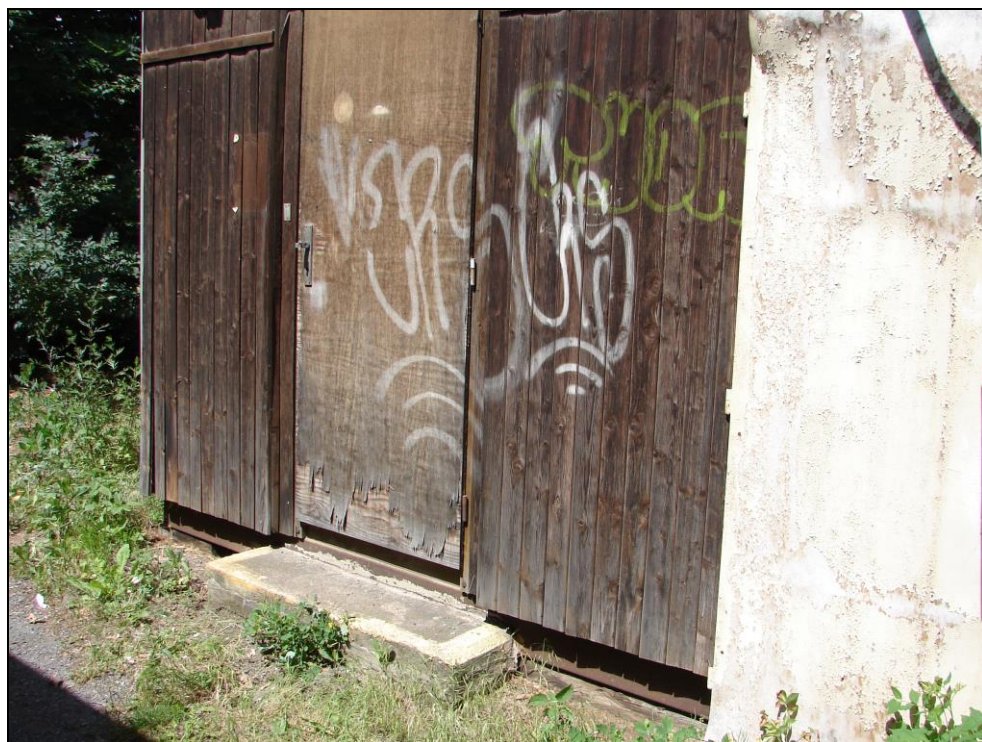
Foto 174 a 175: SO 03-55-01, stavební buňka, demolice č. 9; pohled na buňku, sendvičové stěnové panely (foto 178 a 179) jsou částečně pobity palubkami a částečně plechem, betonový schod, šipkou vyznačena rozvodná krabice el. energie (foto 176)
