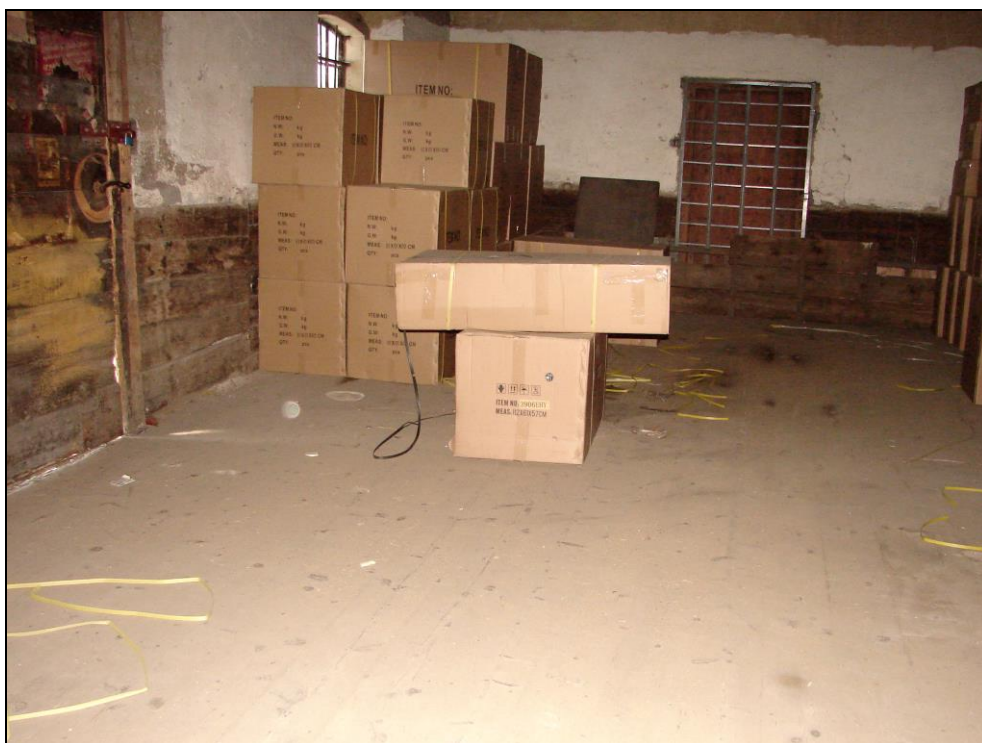
Foto 99 a 100: SO 03-55-01, sklad, interiér, hlavní skladovací prostor; omítnuté zděné stěny, dřevěný krov, dřevěná podlaha (foto 103), šipkou je vyznačena deska na bázi cementu pod osvětlením (podrobně foto 107)
