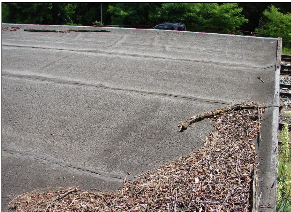
Foto 63: SO 02-55-01, hradlo závodiště, střecha; střešní krytina ze 4 vrstev asfaltových lepenek prokládaných asfaltovým nátěrem, ze souvrství lepenek byl odebrán vzorek (foto 73), asfaltové lepenky neobsahují azbest jako plnivo
