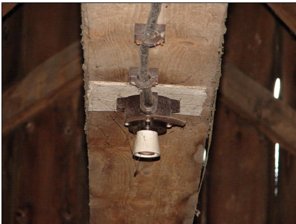
Foto 111 a 112: SO 03-55-01, sklad, interiér, dřevěná část skladu; deska na bázi cementu pod osvětlením (na foto nahoře vyznačena šipkou), deska na bázi cementu obsahuje azbestová vlákna
