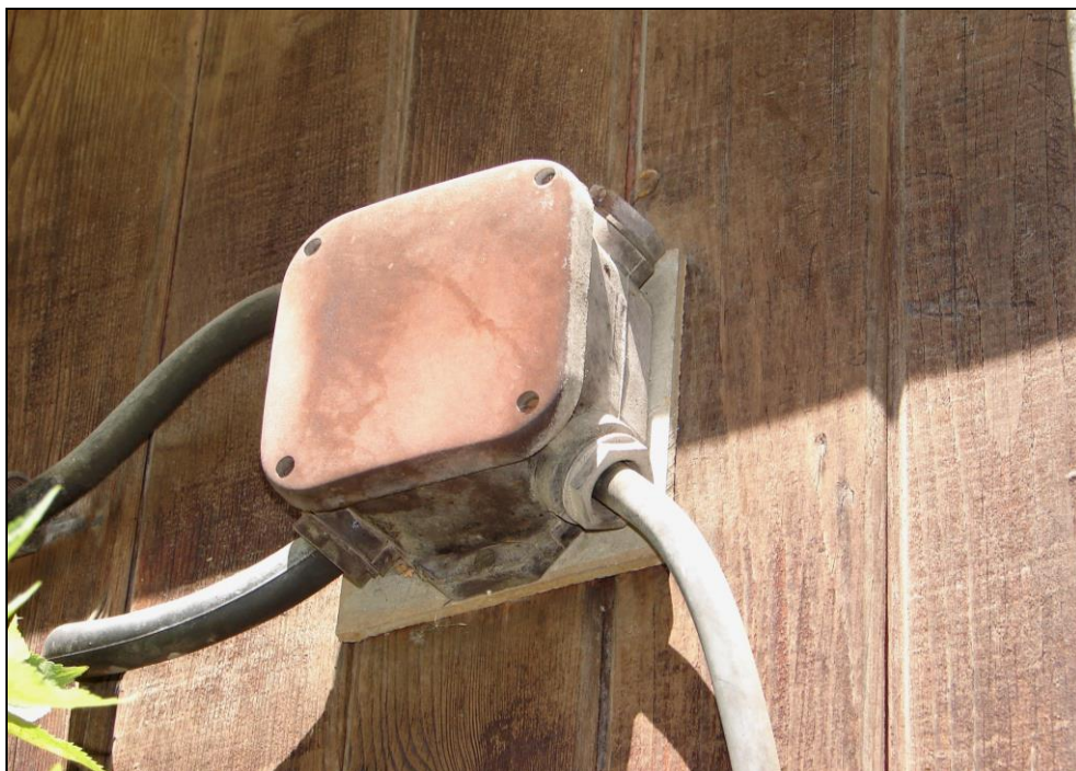
Foto 150: SO 03-55-01, stavební buňka, demolice č. 7; rozvodná krabice el. energie z foto 148, pod krabicí je deska na bázi cementu, deska na bázi cementu obsahuje azbestová vlákna
