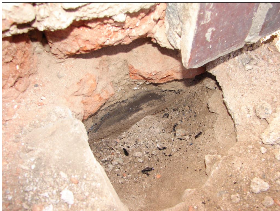
Foto 245: SO 03-55-01, trafostanice; sonda pro zjištění spodní izolace, jako spodní izolace zjištěn litý asfalt, z asfaltu byl odebrán vzorek (foto 266), litý asfalt není klasifikován jako nebezpečný materiál
