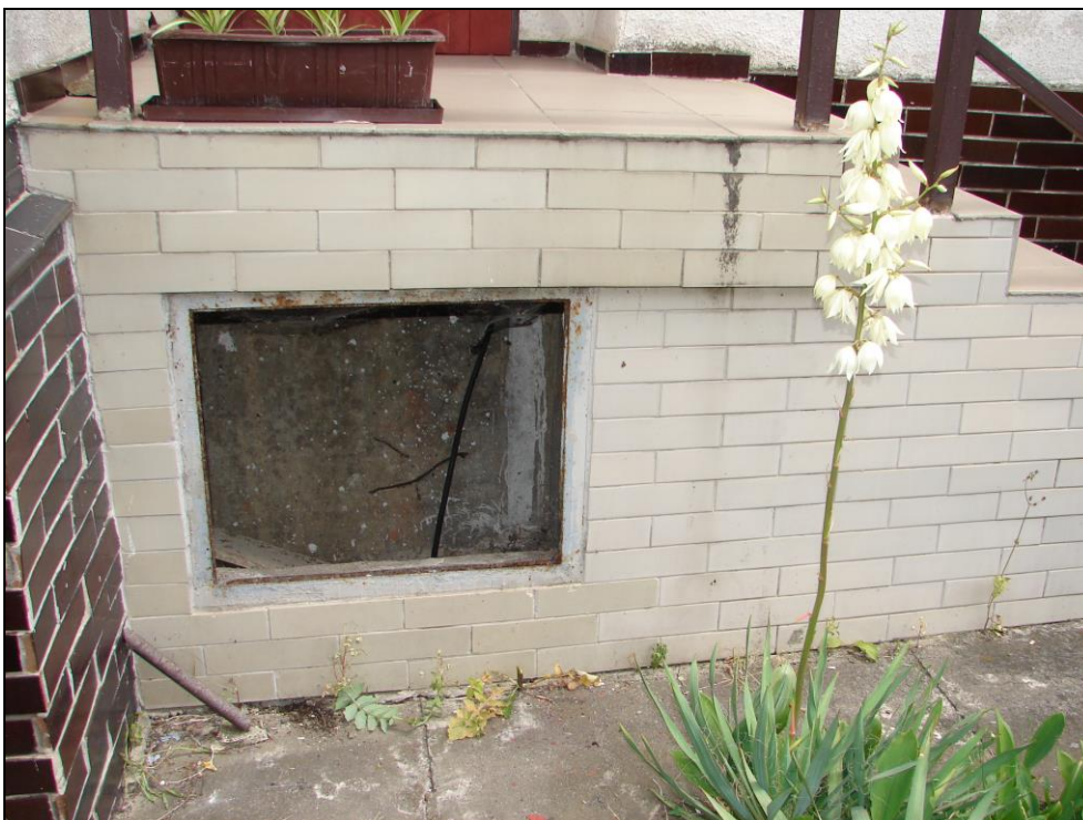
Foto 5: SO 02-55-01, hradlo Barrandov; otvor do prostoru pod ŽB vstupním schodištěm, plechová dvířka jsou již sejmuta
