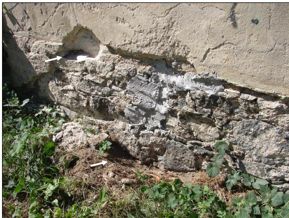
Foto 122: SO 03-55-01, sklad, sondy pro zjištění spodní izolace; štítová stěna, sondy v úrovni terénu a úrovni rampy (vyznačeny šipkami), spodní izolace nezjištěna
