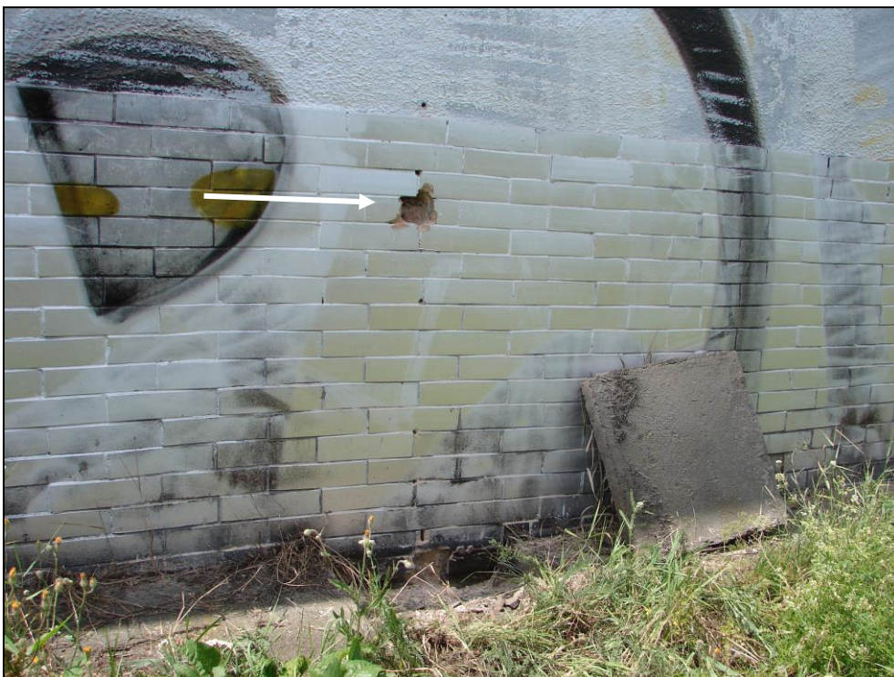
Foto 29: SO 02-55-01, hradlo Barrandov, sonda pro zjištění spodní izolace; šipka vyznačuje úroveň, ve které byl zjištěn asfaltový hydroizolační pás, nad izolací zdivo z děrovaných cihel CD INA, pod izolací beton (foto 30)
