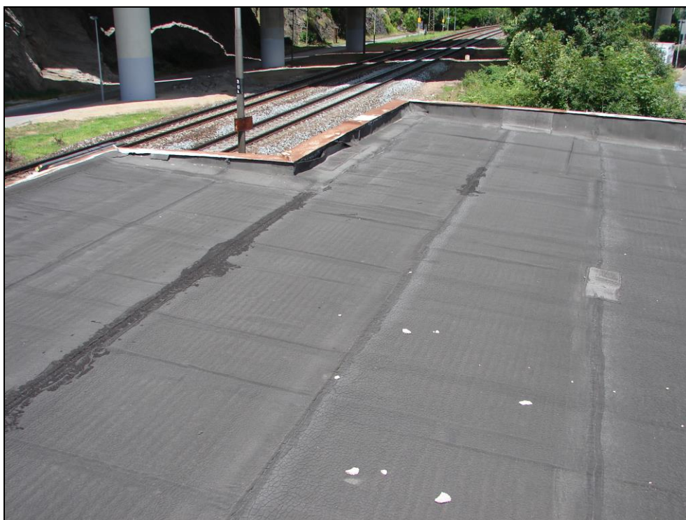
Foto 31: SO 02-55-01, hradlo Barrandov, střecha; asfaltové hydroizolační pásy se skelnou tkaninou (foto 32),
