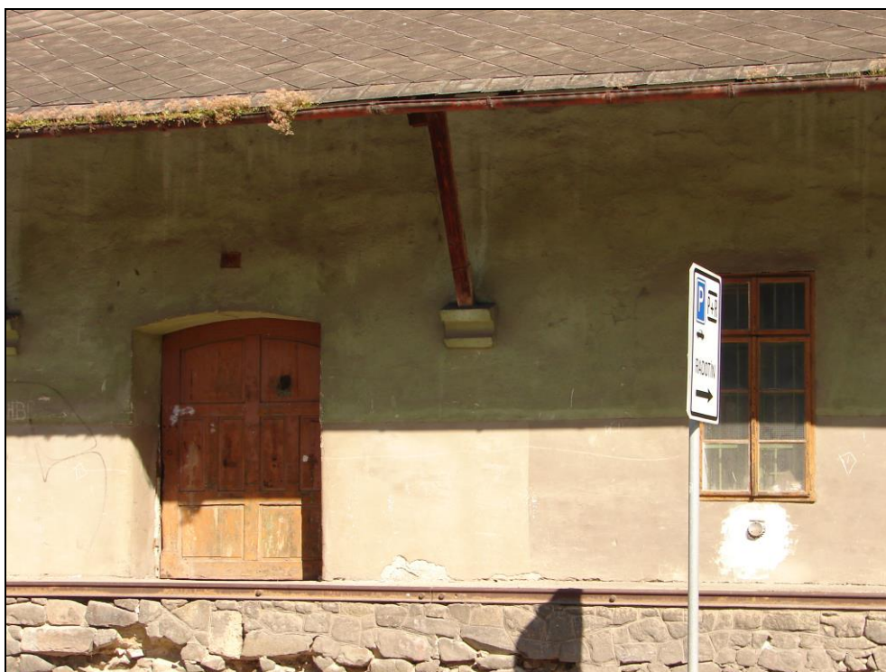
Foto 83: SO 03-55-01, sklad; obvodová stěna do ulice (foto 75), dřevěné okno a dřevěná vrata
