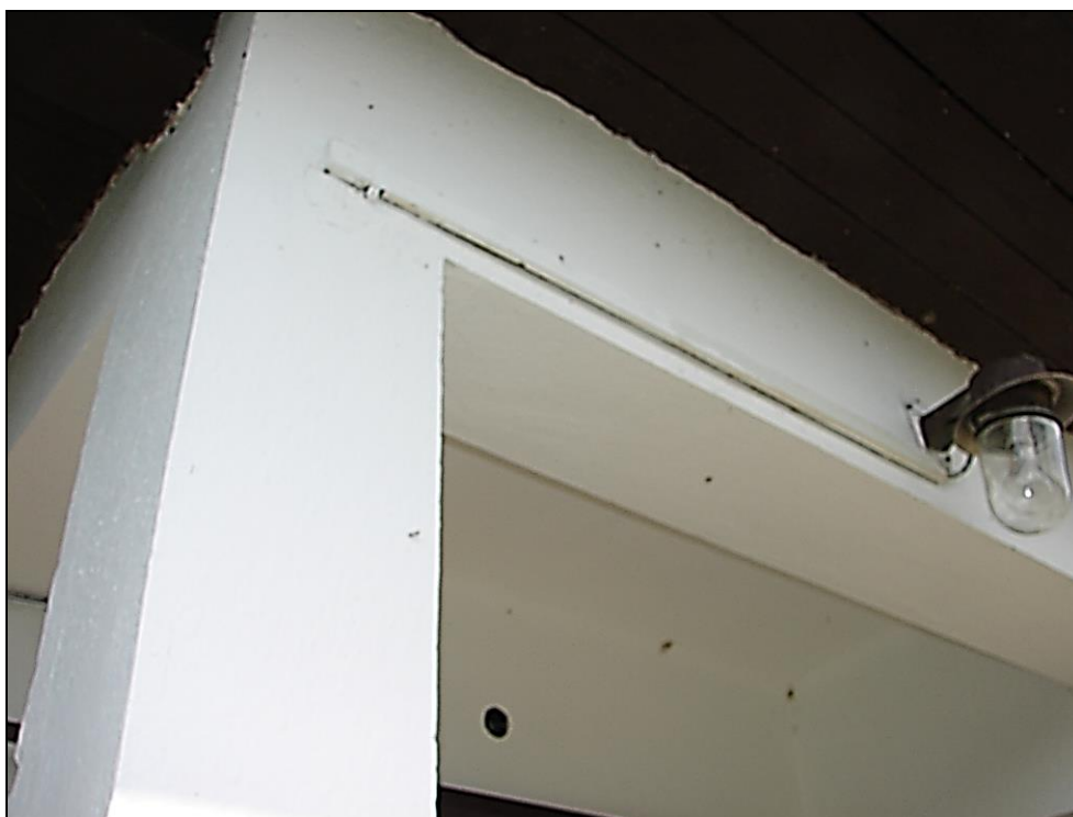
Foto 43: SO 02-55-01, hradlo závodiště; betonové / ŽB nadpraží, zjištěno vrtem Ø 10 mm
