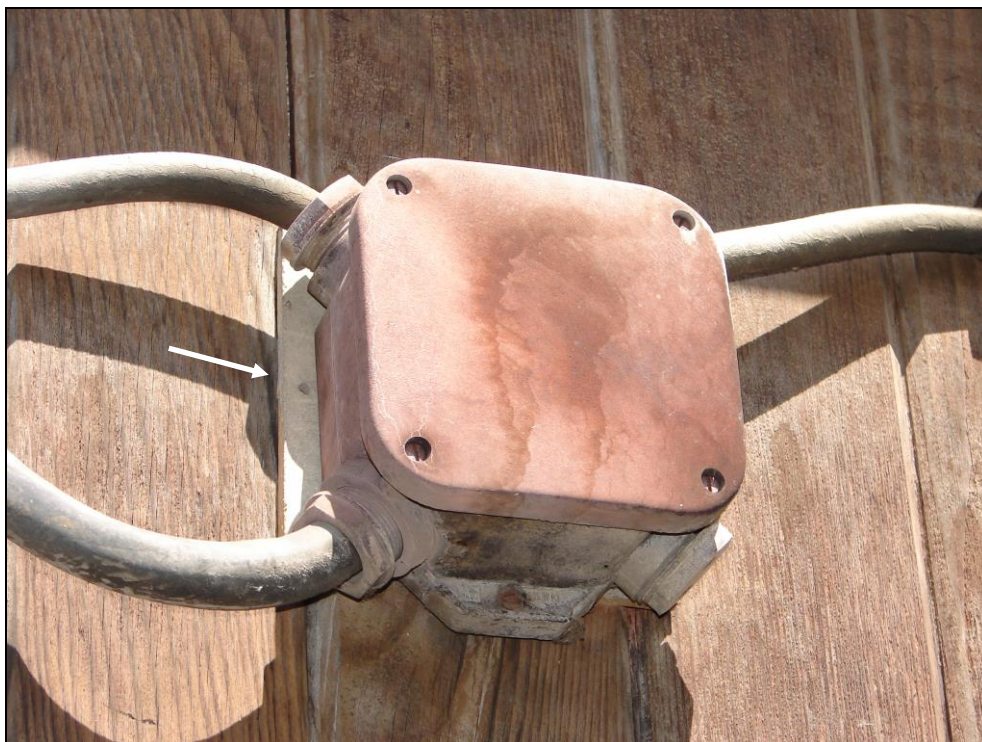
Foto 162: SO 03-55-01, stavební buňka, demolice č. 8; rozvodná krabice el. energie z foto 160, pod krabicí je deska na bázi cementu (šipka), deska na bázi cementu obsahuje azbestová vlákna
