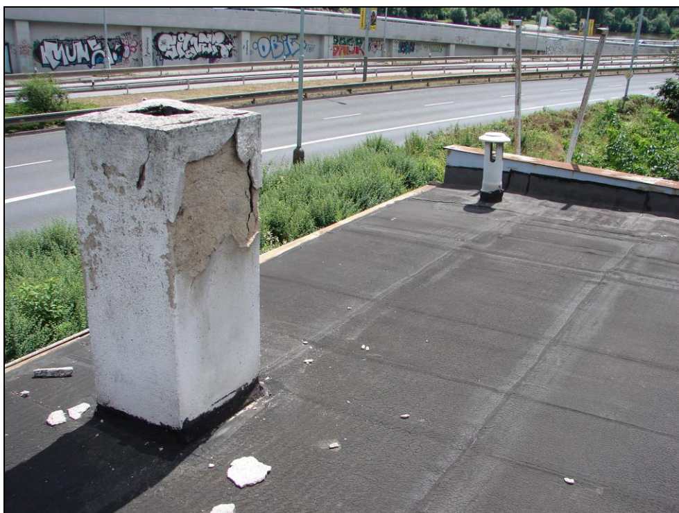
Foto 33: SO 02-55-01, hradlo Barrandov, střecha; zděný komín (foto 34), plastová odvětrávací roura (foto 13)
