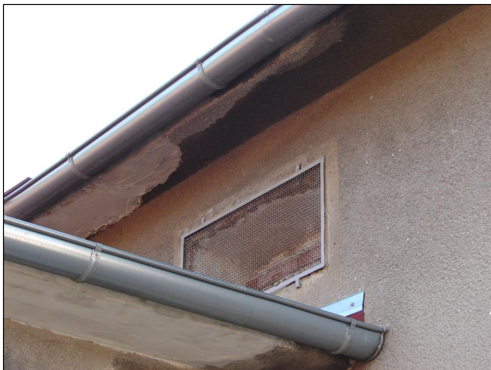
Foto 259: SO 03-55-01, trafostanice, střecha; kovové okapní žlaby, kovová větrací mřížka
