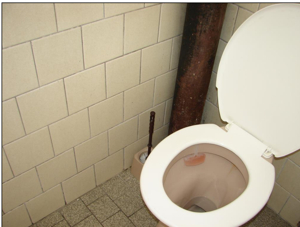
Foto 13 a 14: SO 02-55-01, hradlo Barrandov, interiér, soc. zařízení, WC; omítnuté zděné stěny a ŽB strop, keramický obklad stěn, kovové okno, na betonové podlaze keramická dlažba, litinová odvětrávací roura pod stropem plastový kus (šipka), který ústí nad střechu (foto 33)
