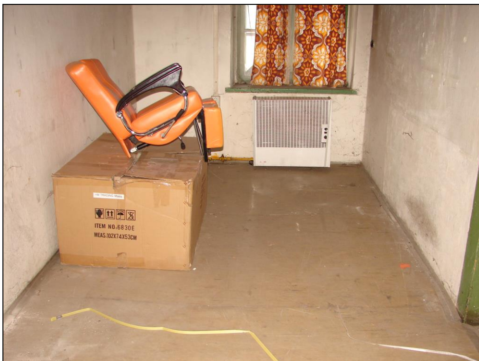
Foto 97 a 98: SO 03-55-01, sklad, interiér, místnost mezi hlavním skladovacím prostorem a rohovou místností; omítnuté zděné stěny a dřevěný strop, dřevěné okno, na betonové podlaze PVC, (na omítkách stopy po lokálním požáru [3])
