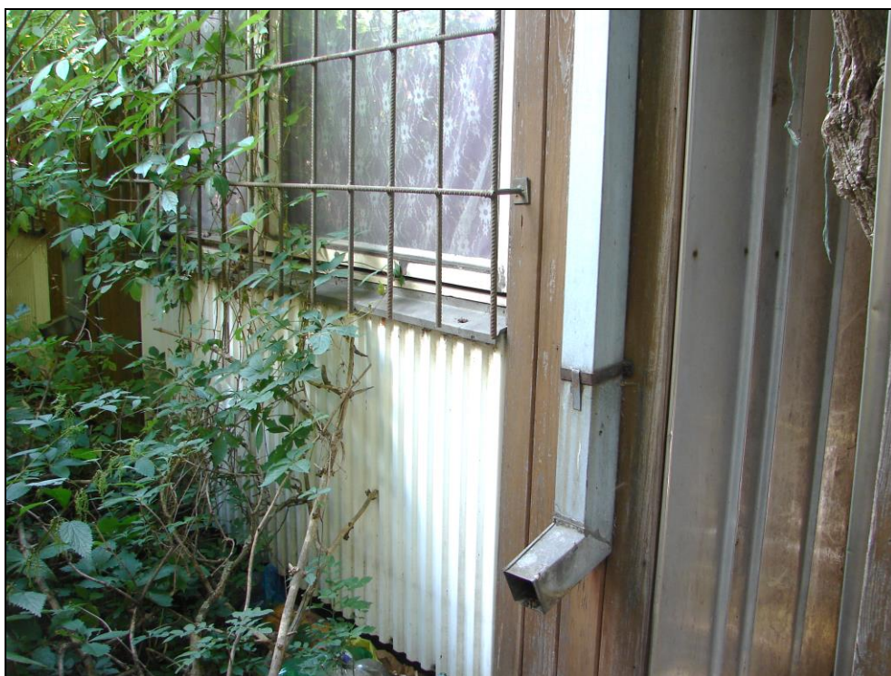
Foto 163: SO 03-55-01, stavební buňka, demolice č. 8; zadní stěna pobitá plechem, dřevěné okno
