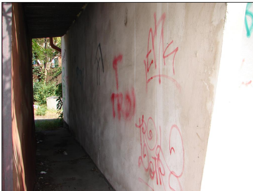
Foto 199: SO 03-55-01, domek TO, levá fasáda domku při pohledu od trati; omítnutá montovaná panelová konstrukce (foto 201 a 202)
