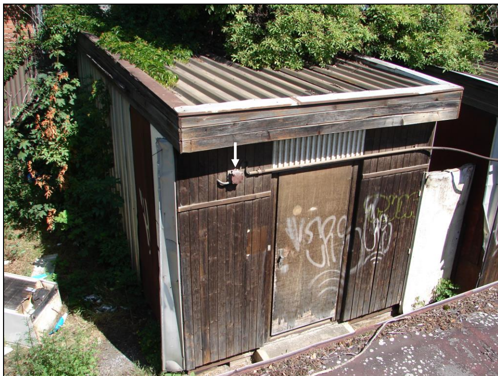
Foto 172: SO 03-55-01, stavební buňka, demolice č. 9; pohled na buňku, sendvičové stěnové panely (foto 178 a 179) jsou částečně pobity palubkami a částečně plechem, šipkou vyznačena rozvodná krabice el. energie (foto 176)
