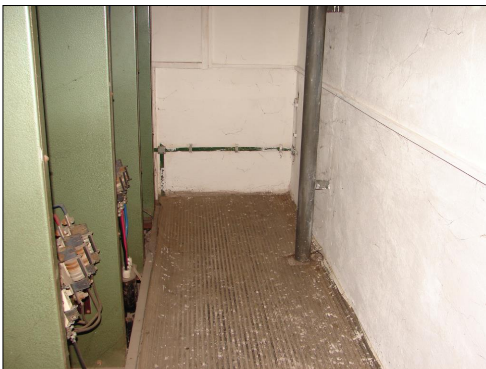
Foto 248 a 249: SO 03-55-01, trafostanice, interiér, rozvodna NN; omítnuté zděné stěny a ŽB strop, vedení v kovové chráničce, na betonové podlaze antistatická pryž
