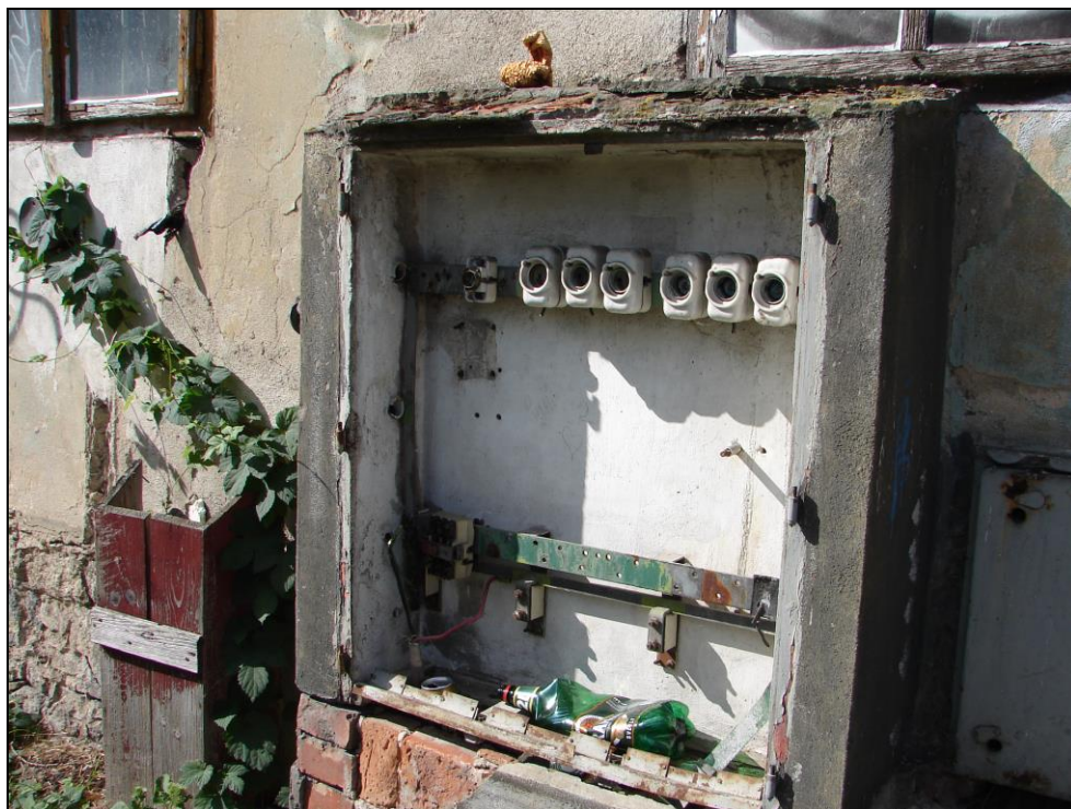
Foto 81: SO 03-55-01, sklad; zděný nefunkční rozvaděč el. energie na štítové stěně (foto 76)
