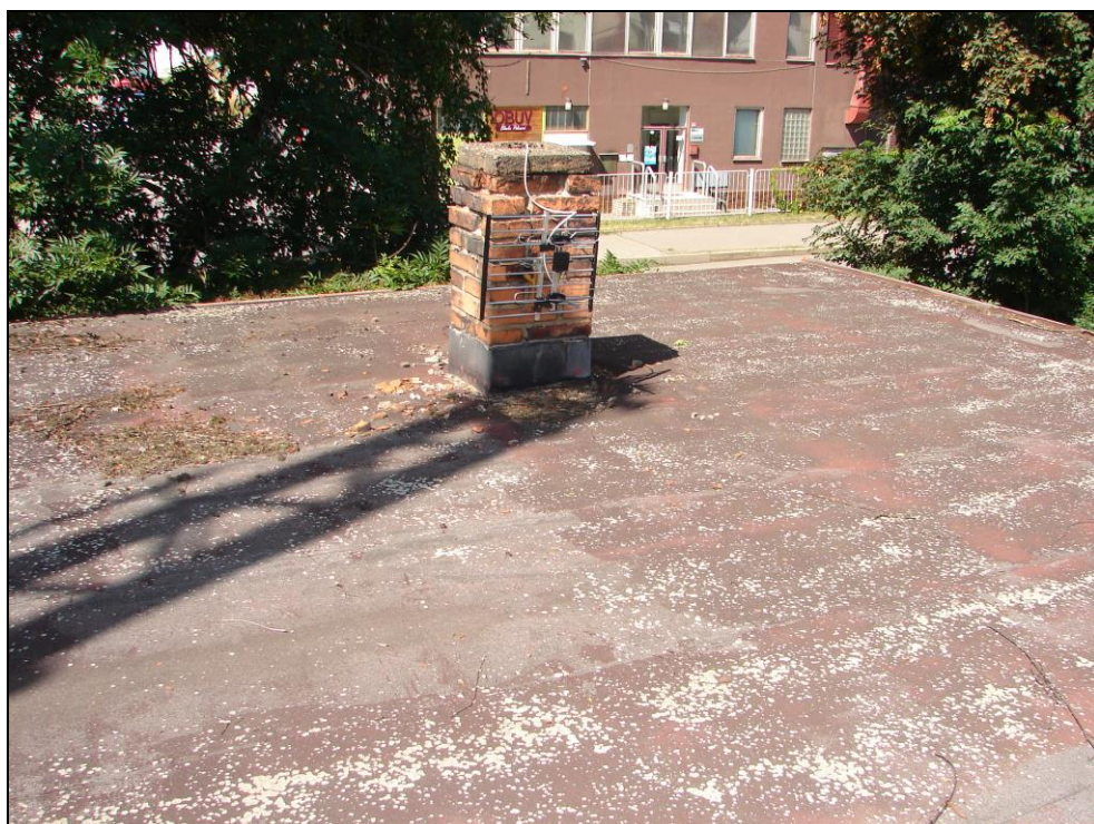
Foto 230: SO 03-55-01, domek TO, střecha; druhý zděný komín (foto 232), střešní krytina ze souvrství asfaltových lepenek pojených litým asfaltem, z asfaltových lepenek byly odebrány vzorky (foto 236 a 237), asfaltové lepenky neobsahují azbest jako plnivo
