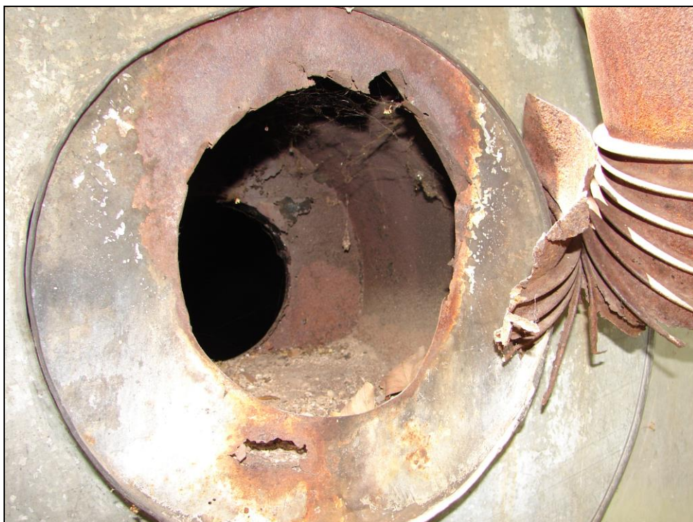
Foto 158 a 159: SO 03-55-01, stavební buňka, demolice č. 7, interiér; průchodka stěnou pro kamnovou rouru (foto 151), materiál pouze plech
