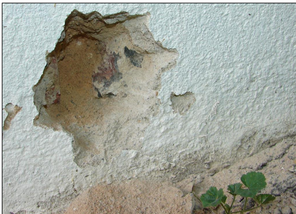
Foto 42: SO 02-55-01, hradlo závoďiště; zděné stěny z plných cihel (CP), sonda pro zjištění materiálu stěn
