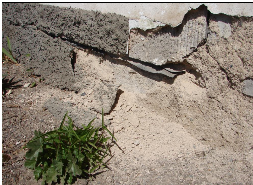
Foto 201: SO 03-55-01, domek TO, fasáda domku směrem k trati; sonda pro zjištění materiálu stěn a spodní izolace, stěny jsou montované z panelů z polystyren-betonu (foto 202), jako spodní izolace zjištěna asfaltová lepenka, z asfaltové lepenky byl odebrán vzorek (foto 235), asfaltová lepenka neobsahuje azbest jako plnivo
