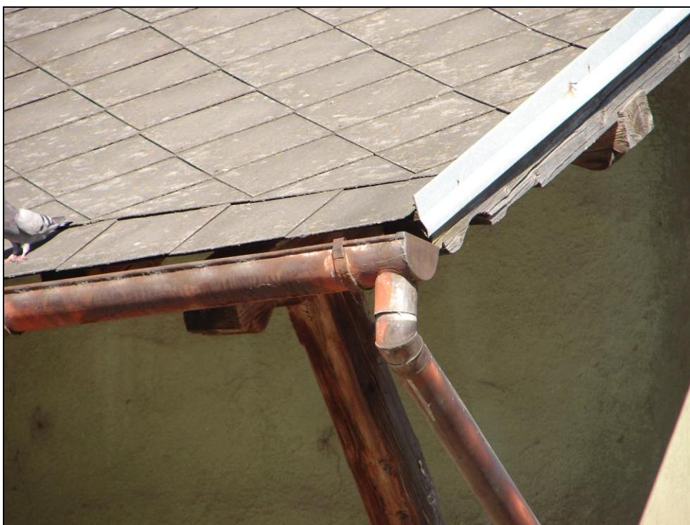
Foto 119 a 120: SO 03-55-01, sklad, střecha; zděný komín, plechový okapní žlab i svod, krytina ze střešních šablon na bázi cementu, zjištěny opticky světlejší a tmavší šablony, z obou typů šablon byl odebrán vzorek (foto 132 a 133), střešní šablony na bázi cementu obsahují azbestová vlákna
