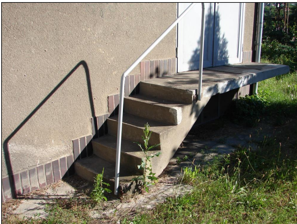
Foto 265: SO 03-55-01, trafostanice, okolí; u vstupu do rozvodny VN betonová dlažba a ŽB schodiště s rampou (foto 238)
