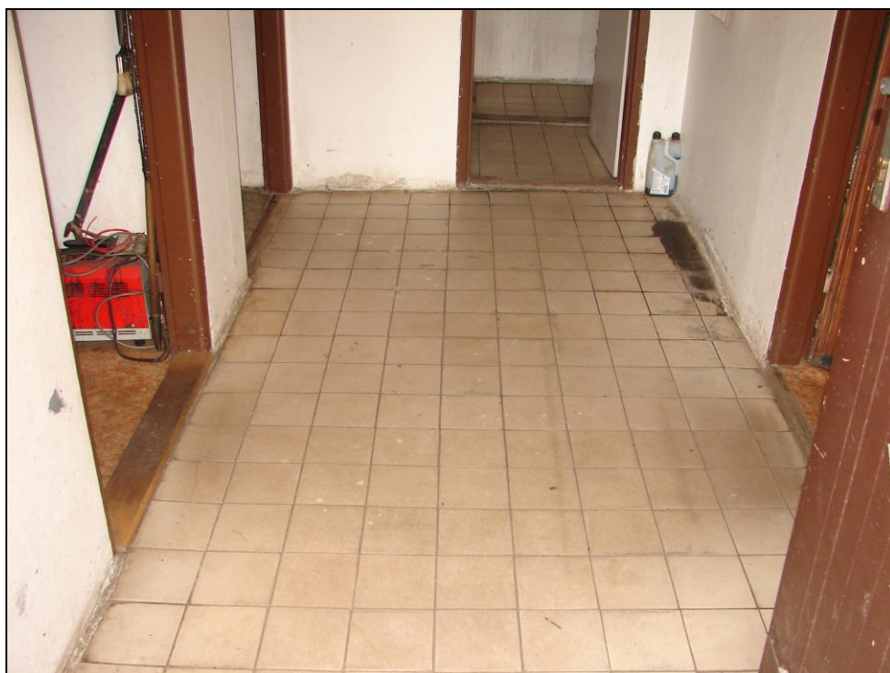
Foto 204 a 205: SO 03-55-01, domek TO, interiér, chodba 1 (foto 203); omítnutý strop a stěny z panelů, el. rozvody v plastových nebo na kovových lištách, na betonové podlaze keramická dlažba
