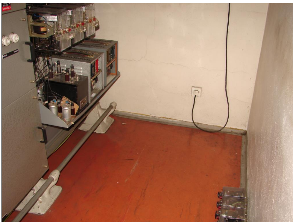
Foto 25 a 26: SO 02-55-01, hradlo Barrandov, interiér, zabezpečovací místnost; omítnuté zděné stěny a ŽB strop, na betonové podlaze PVC, el. rozvody uchyceny na kovových lištách
