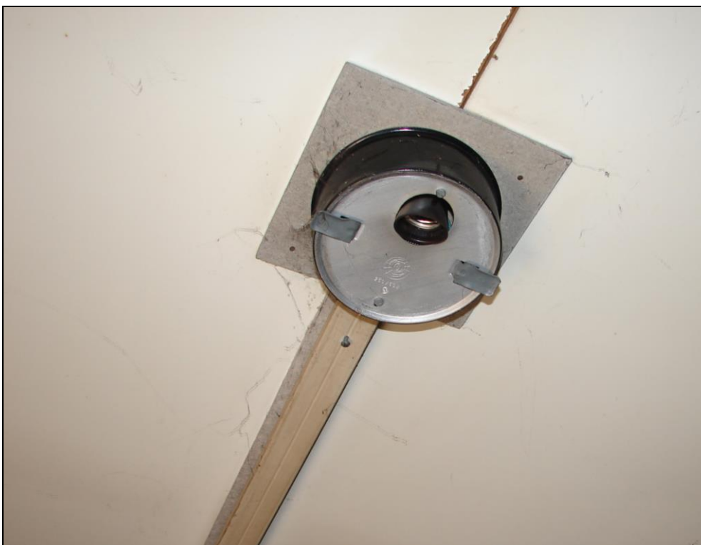
Foto 182 a 183: SO 03-55-01, stavební buňka, demolice č. 9, interiér; dřevěné okno, stropní a stěnové sendvičové panely (foto 179), pod osvětlením na stropě, plastovými lištami s el. rozvody a zásuvkami jsou desky na bázi cementu (foto 184 - 187), desky na bázi cementu obsahují azbestová vlákna
