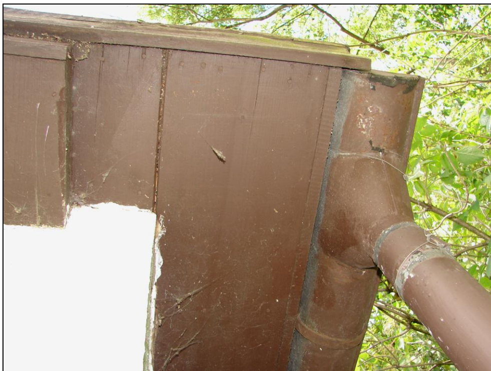
Foto 61: SO 02-55-01, hradlo závoďiště, střecha; dřevěné podbití, plechový okapní žlab i svod
