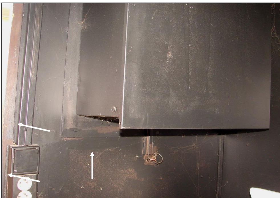
Foto 156: SO 03-55-01, stavební buňka, demolice č. 7, interiér; pod plastovými lištami s el. rozvody, vypínačem, zásuvkou a el. rozvaděčem u vstupu jsou desky na bázi cementu (viz šipky), desky na bázi cementu obsahují azbestová vlákna
