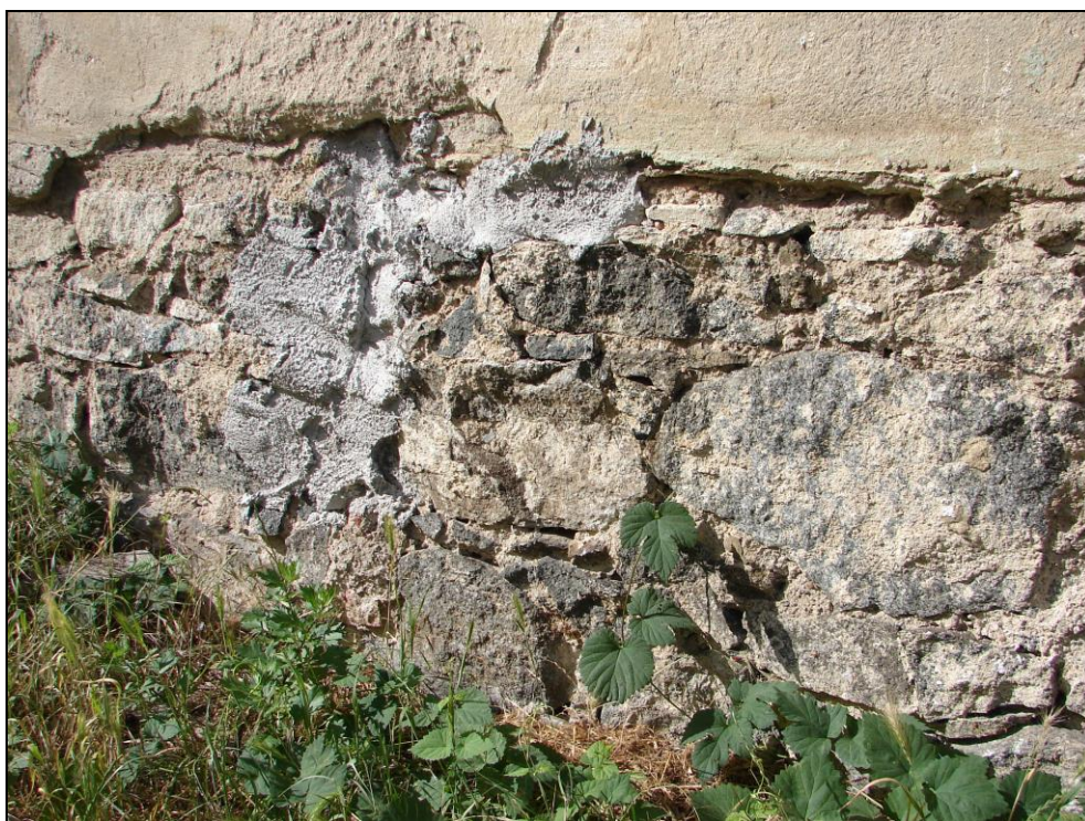
Foto 80: SO 03-55-01, sklad; obvodové kamenné zdivo s podílem cihel (CP), štítová stěna (foto 76)
