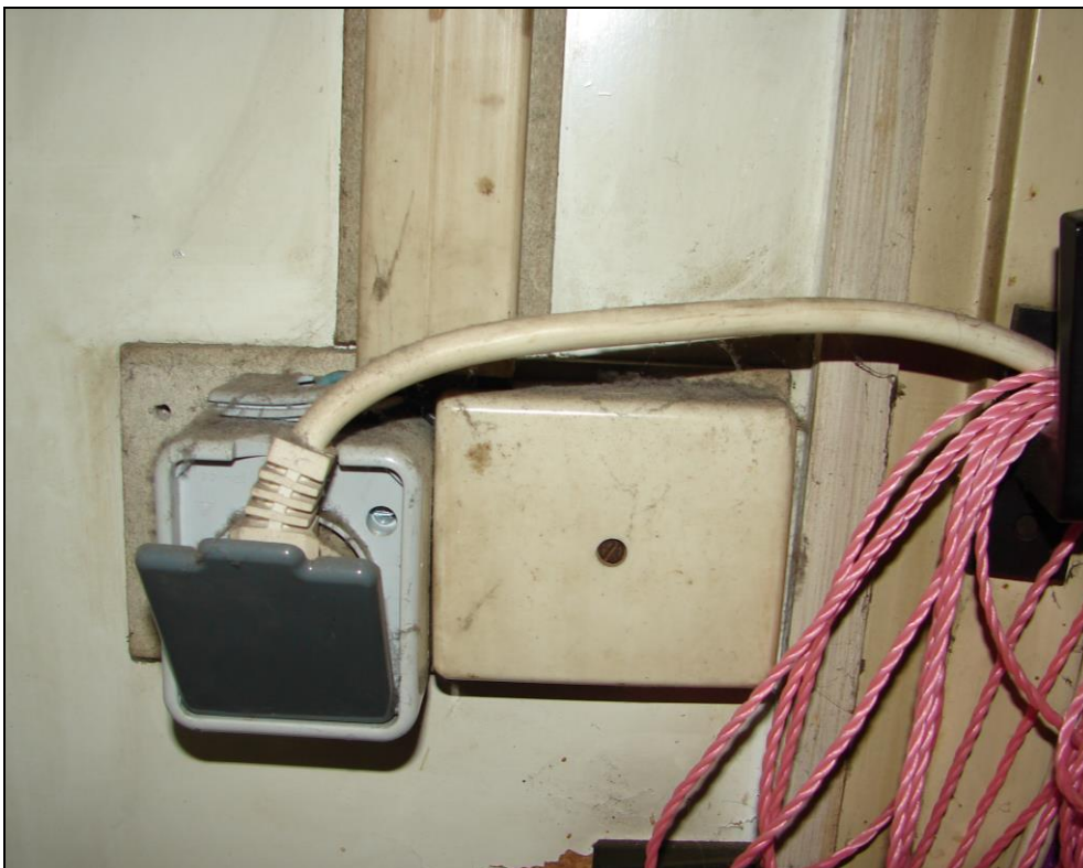
Foto 166 a 167: SO 03-55-01, stavební buňka, demolice č. 8, interiér; pod osvětlením na stropě, plastovými lištami s el. rozvody a zásuvkami jsou desky na bázi cementu, desky na bázi cementu obsahují azbestová vlákna
