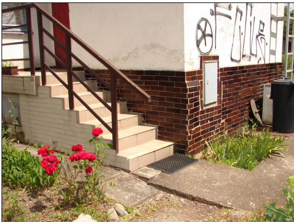
Foto 4: SO 02-55-01, hradlo Barrandov; pohled na hradlo směrem k mostu, ŽB vstupní schodiště do hradla s keramickou dlažbou a obkladem, ocelové zábradlí
