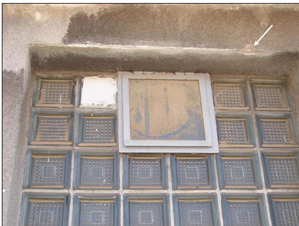
Foto 241: SO 03-55-01, trafostanice, fasáda směrem k trati; zasklení z luxferů (vyznačeno šipkou na foto 240), v kovovém rámu skleněná (zašpiněná) tabule, šipkou vyznačena sonda pro zjištění materiálu nadpraží, zjištěn beton (foto 242)
