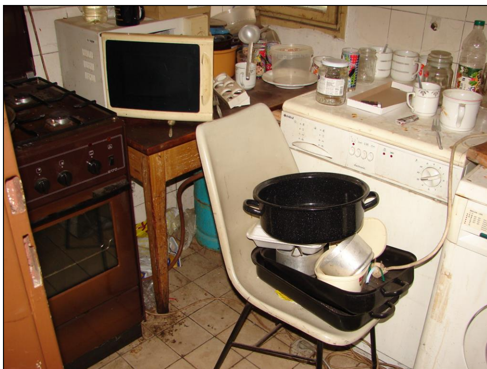
Foto 216 a 217: SO 03-55-01, domek TO, interiér, kuchyňka (foto 203); omítnutý strop a stěny z panelů, na stěnách částečně keramický obklad, dřevěné okno, el. rozvody na kovových lištách, na betonové podlaze keramická dlažba
