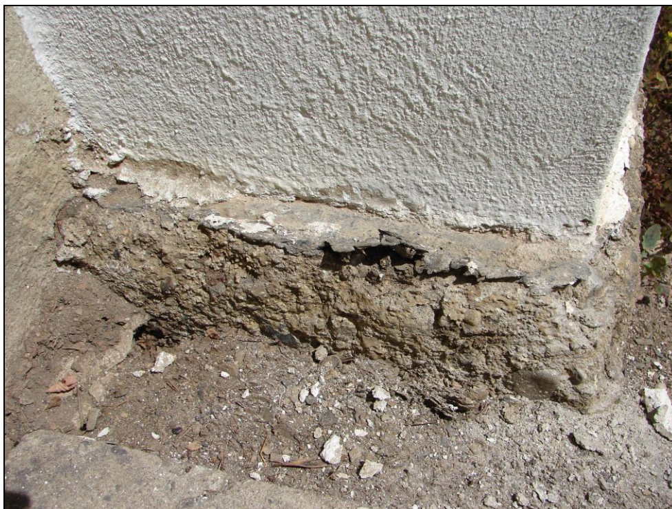
Foto 65 a 66: SO 02-55-01, hradlo závodiště; sonda pro zjištění spodní izolace, zjištěna asfaltová lepenka opatřená asfaltovým nátěrem, z asfaltové lepenky byl odebrán vzorek (foto 74), asfaltová lepenka neobsahuje azbest jako plnivo
