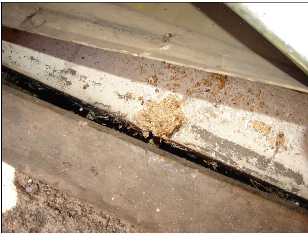
Foto 191: SO 03-55-01, stavební buňka, demolice č. 9, interiér; podlaha z dřevotřískových desek (stejně u všech buněk)
