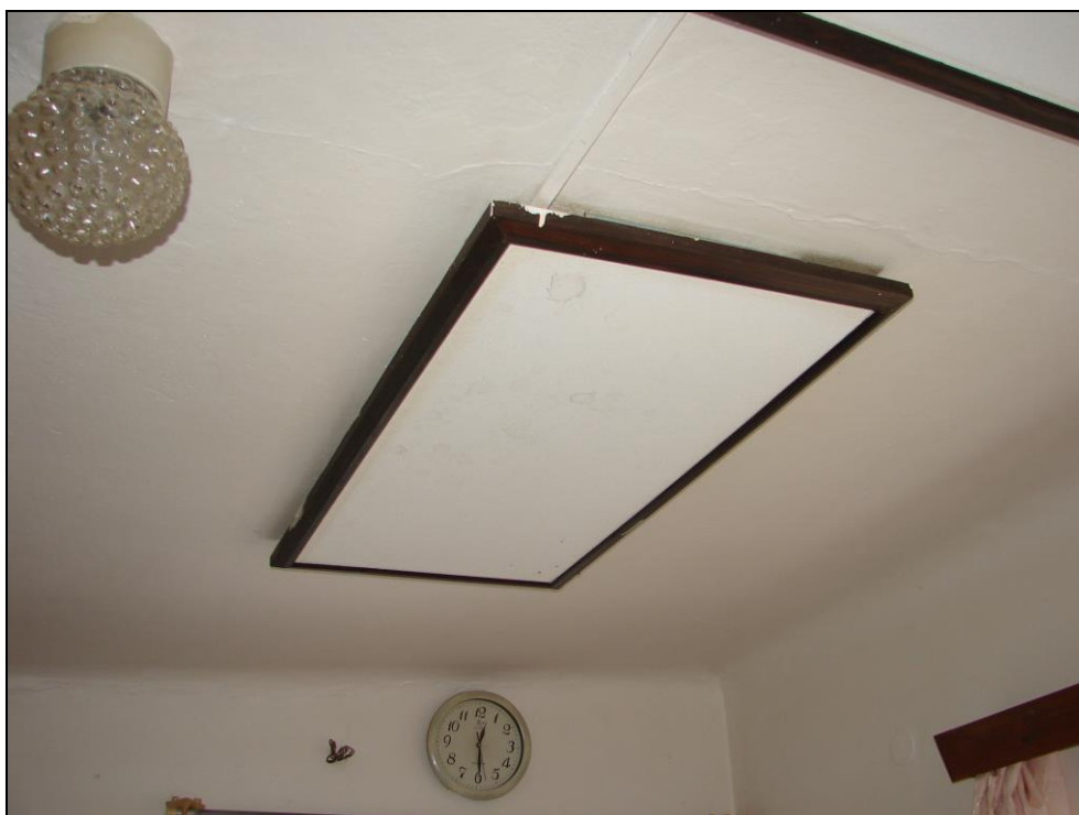
Foto 55: SO 02-55-01, hradlo závodiště, interiér, hlavní místnost; omítnuté zděné stěny a dřevěný strop, na stropě vyhřívací panel (foto 47 a 56)
