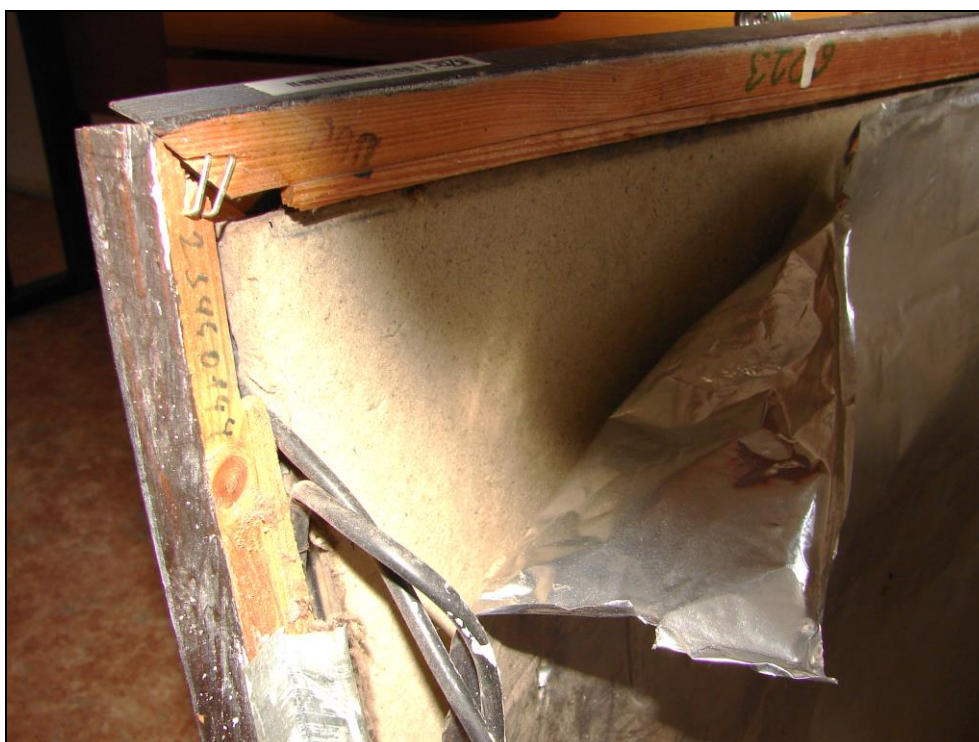
Foto 56: SO 02-55-01, hradlo závodiště, interiér, hlavní místnost; vyhřívací panel, dřevěný rám, na rubu hliníkové fólie, topná spirála uložena v tvrzené minerální vlně
