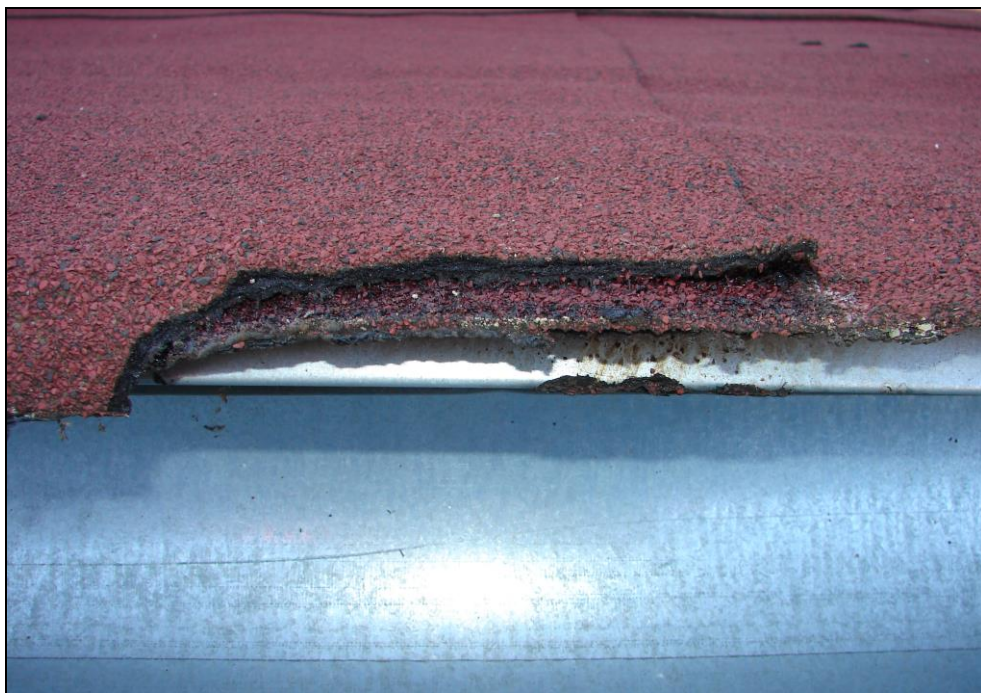
Foto 262: SO 03-55-01, trafostanice, střecha; střešní krytina z asfaltových hydroizolačních pásů (cca z r. 2012 [3]), z asfaltového hydroizolačního pásu byl odebrán vzorek (foto 267) - viz též kap. 5.4, asfaltový hydroizolační pás neobsahuje azbest jako plnivo
