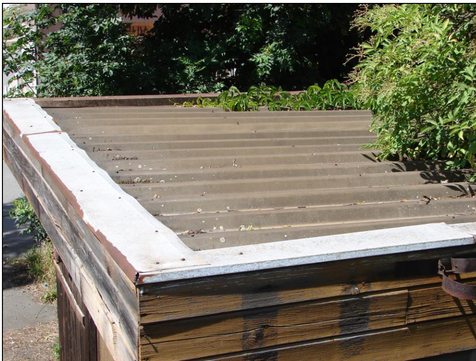
Foto 173: SO 03-55-01, stavební buňka, demolice č. 9, střecha; střešní krytina z trapézového plechu
