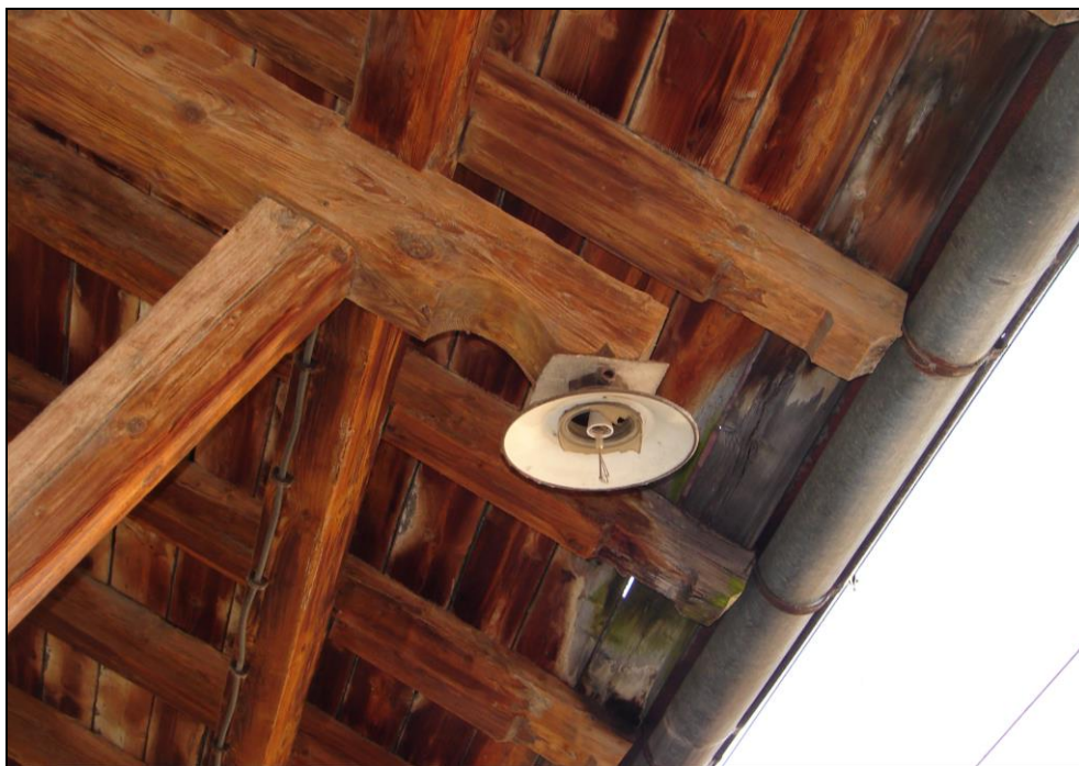
Foto 85: SO 03-55-01, sklad; jedno z venkovních osvětlení rampy, pod osvětlením je deska na bázi cementu, vzorek byl odebrán z desky pod osvětlením v interiéru (foto 107 a 131), deska na bázi cementu obsahuje azbestová vlákna
