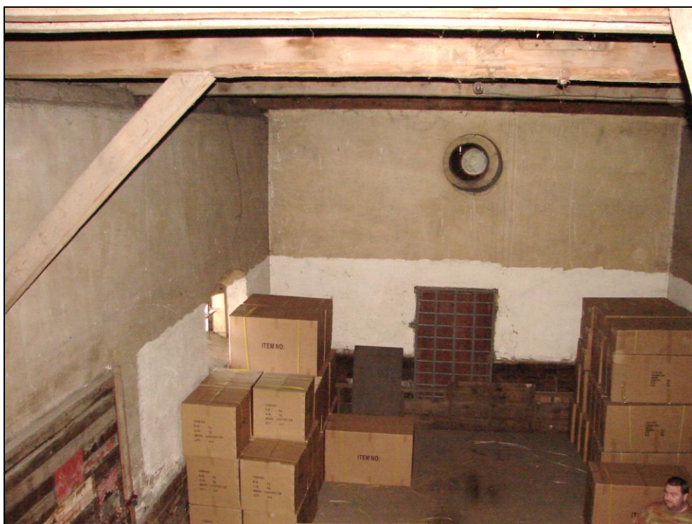
Foto 109 a 110: SO 03-55-01, sklad, interiér, hlavní skladovací prostor; omítnuté zděné stěny, dřevěný krov, dřevěná podlaha, kruhové okno v dělicí stěně, kruhovým oknem byla prohlédnuta jinak nepřístupná dřevěná část skladu (foto 78 a 108)
