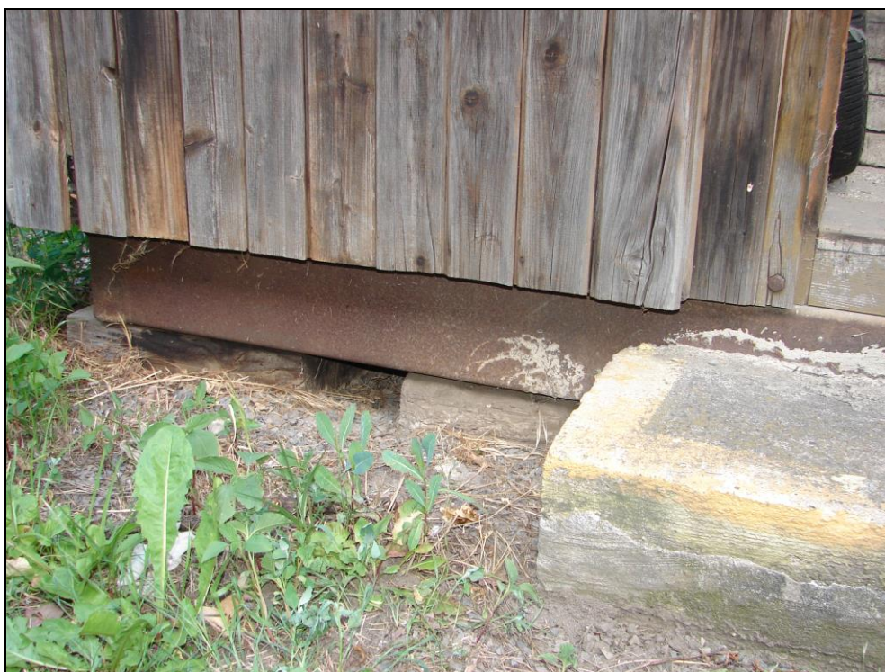
Foto 177: SO 03-55-01, stavební buňka, demolice č. 9; nosná ocelová konstrukce podložená betonovými prvky, betonový schod
