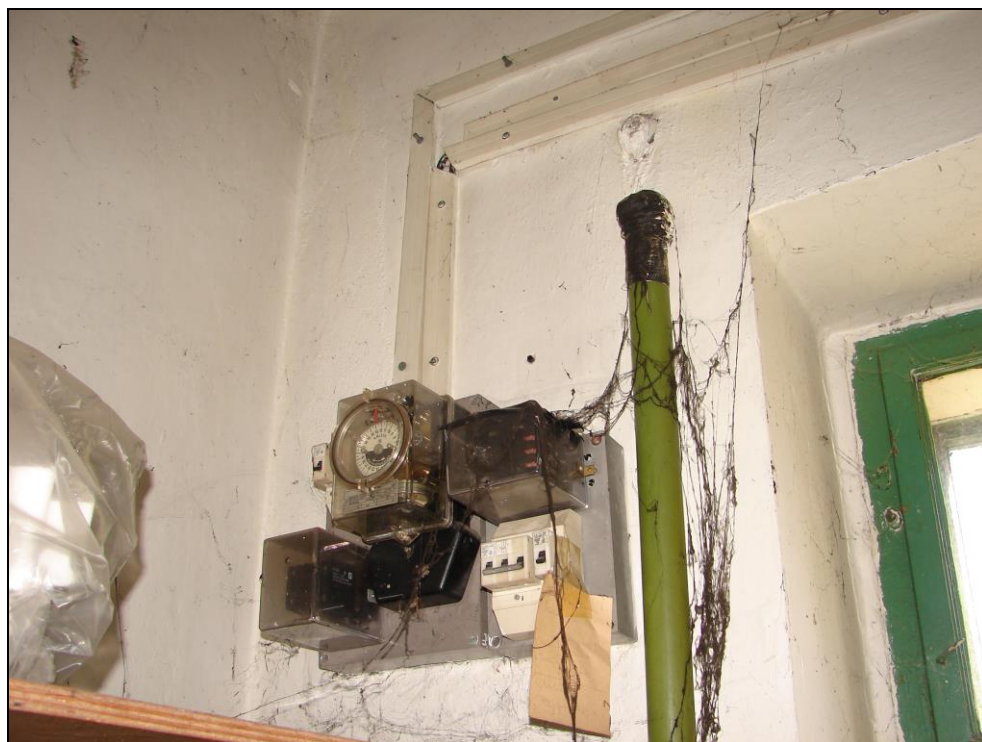
Foto 90: SO 03-55-01, sklad, interiér, předsíň; omítnuté zděné stěny, dřevěné okno, el. rozvody na plastové desce a v plastových lištách
