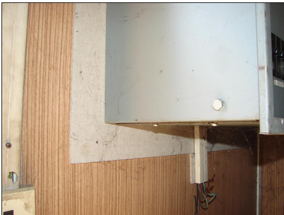
Foto 188 a 189: SO 03-55-01, stavební buňka, demolice č. 9, interiér; pod plastovými lištami s el. rozvody, vypínačem a rozvaděčem el. energie jsou desky na bázi cementu, z desky pod rozvaděčem byl odebrán vzorek (foto 194), desky na bázi cementu obsahují azbestová vlákna
