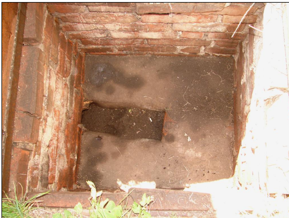
Foto 129: SO 03-55-01, sklad, okolí; zděná kanalizační šachtiice pod ocelovým poklopem z foto 128
