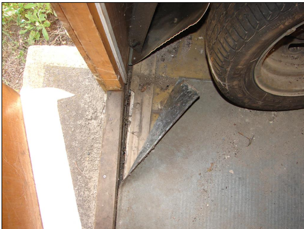
Foto 190: SO 03-55-01, stavební buňka, demolice č. 9, interiér; u vstupu na podlaze prostý plech, PVC na dřevěné podlaze (foto 191) (stejně u všech buněk)
