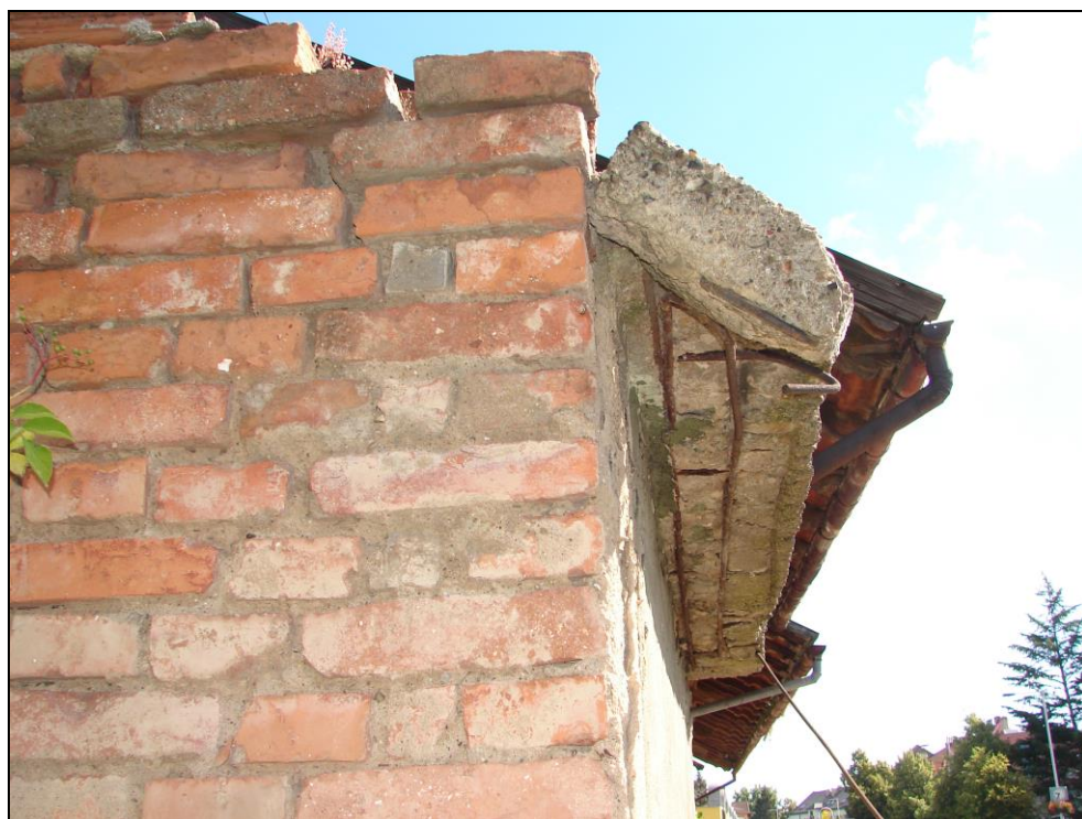
Foto 137: SO 03-55-01, zděný přístavek u skladu; celkový pohled, zděná stěna (CP), železobetonová římsa
