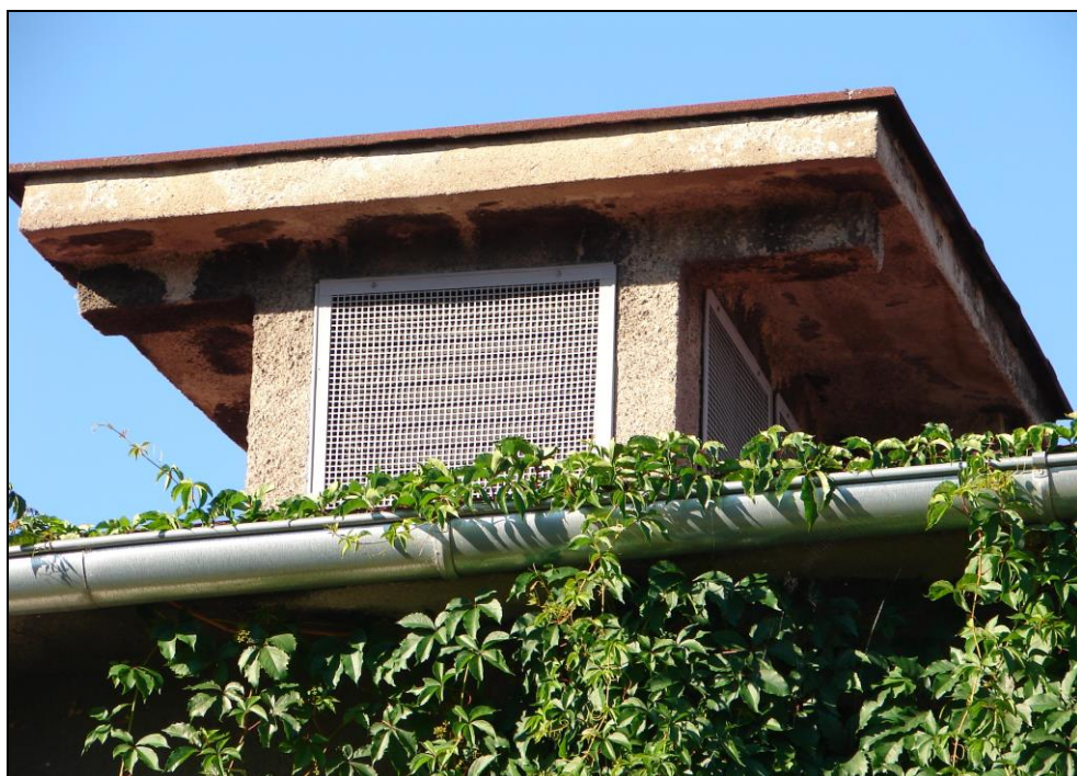
Foto 260: SO 03-55-01, trafostanice, střecha; větrací komínek (foto 239), ŽB deska, kovová větrací mřížka, krytina viz foto 261
