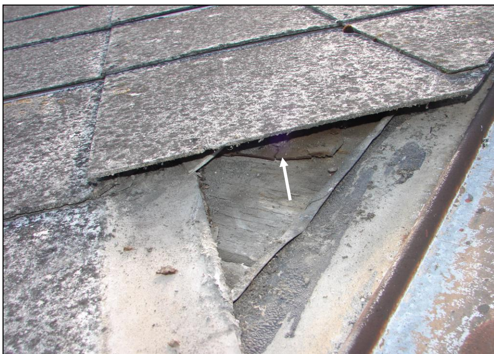
Foto 121: SO 03-55-01, sklad, střecha; krytina ze střešních šablon na bázi cementu, z šablony byl odebrán vzorek (foto 132), střešní šablony na bázi cementu obsahují azbestová vlákna, pod šablonami je asfaltová lepenka (šipka), z asfaltové lepenky byl odebrán vzorek (foto 134), asfaltová lepenka neobsahuje azbest jako plnivo
