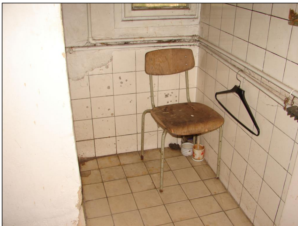
Foto 212 a 213: SO 03-55-01, domek TO, interiér, koupelna (foto 203); omítnutý strop a stěny z panelů, na stěnách částečně keramický obklad, kovové trubky, dřevěné okno, na betonové podlaze keramická dlažba
