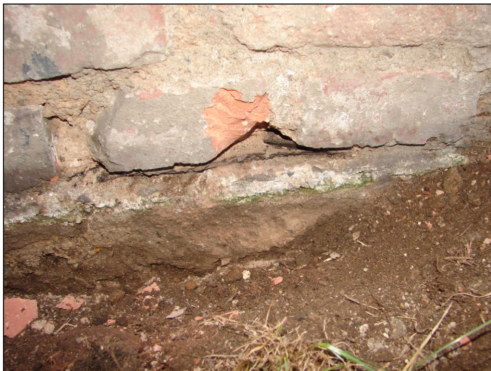
Foto 142: SO 03-55-01, zděný přístavek u skladu; sonda pro zjištění spodní izolace, zjištěna asfaltová lepenka, z asfaltové lepenky byl odebrán vzorek (foto 143), asfaltová lepenka neobsahuje azbest jako plnivo
