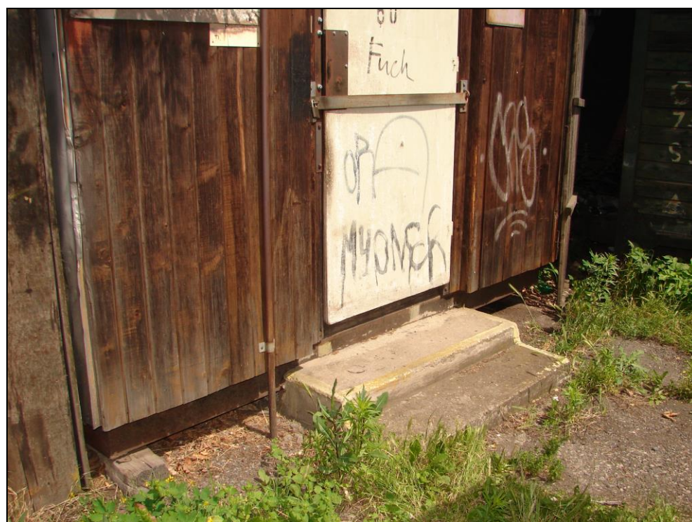
Foto 148 a 149: SO 03-55-01, stavební buňka, demolice č. 7; pohled na buňku, sendvičové stěnové panely (foto 178 a 179) jsou částečně pobity palubkami a částečně plechem, střešní krytina z trapézového plechu částečně překrytá vlnitým plechem a dalším trapézovým plechem (foto 151), betonový schod, šipkou vyznačena rozvodná krabice el. energie (foto 150)
