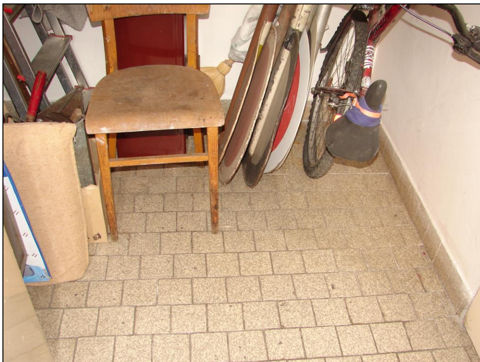
Foto 9 a 10: SO 02-55-01, hradlo Barrandov, interiér, předsíň soc. zařízení; omítnuté zděné stěny a ŽB strop, kovové okno, na betonové podlaze keramická dlažba
