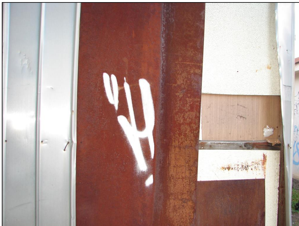
Foto 178: SO 03-55-01, stavební buňka, demolice č. 9; stěna, pod plechem je polystyren a stěnový sendvičový panel (foto 179)
