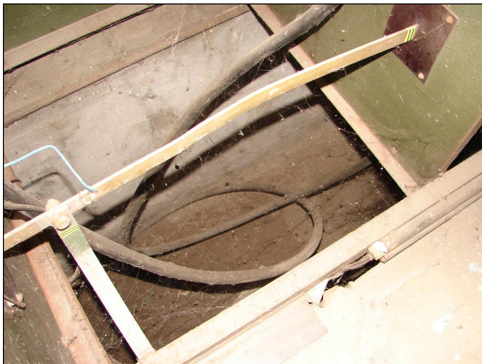
Foto 250: SO 03-55-01, trafostanice, interiér, rozvodna NN; betonový kabelový kanál pod technologií z foto 249
