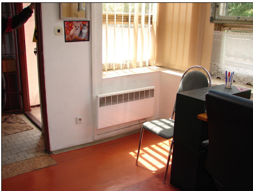
Foto 17 a 18: SO 02-55-01, hradlo Barrandov, interiér, hlavní místnost; omítnuté zděné stěny a ŽB strop, kovová okna a zárubeň, na betonové podlaze PVC, el. rozvod v plastových lištách
