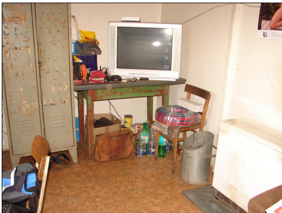
Foto 208 a 209: SO 03-55-01, domek TO, interiér, místnost 1 (foto 203); omítnutý strop a stěny z panelů, el. rozvody na kovových lištách, na betonové podlaze PVC, plech pod akumulacími kamny bez ohnivzdorného materiálu na rubové straně
