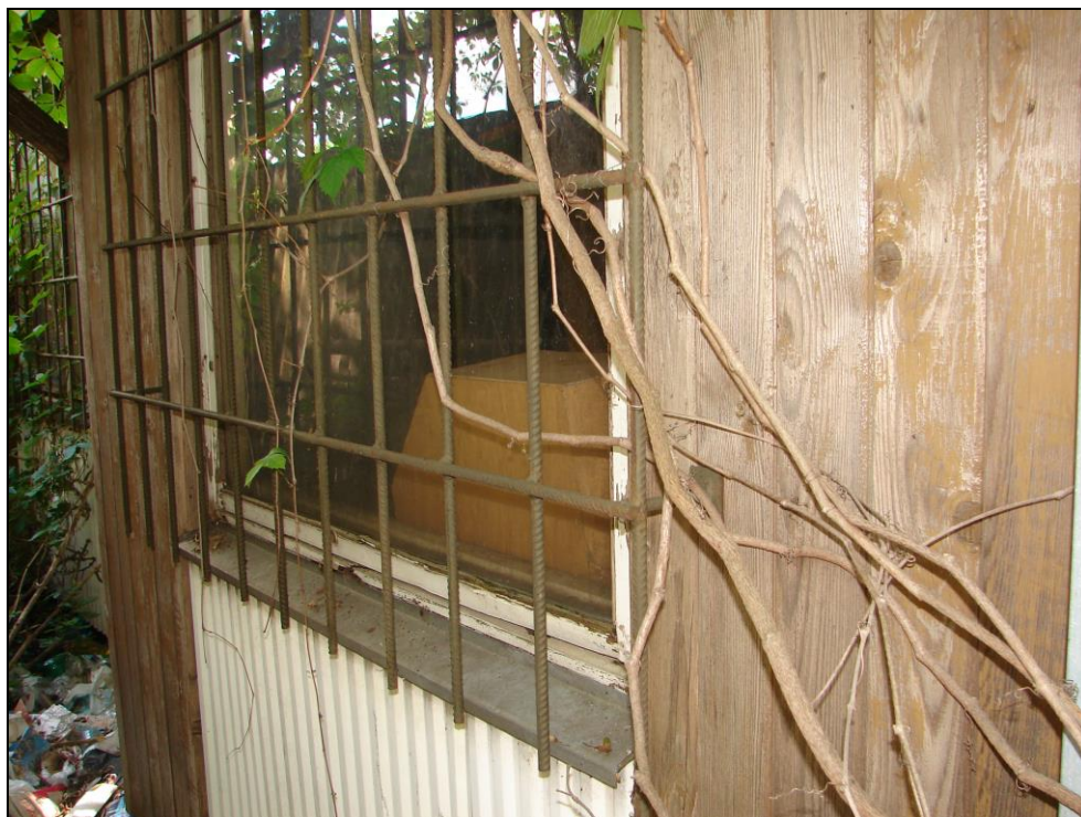
Foto 180: SO 03-55-01, stavební buňka, demolice č. 9; zadní stěna pobitá plechem a palubkami, dřevěné okno
