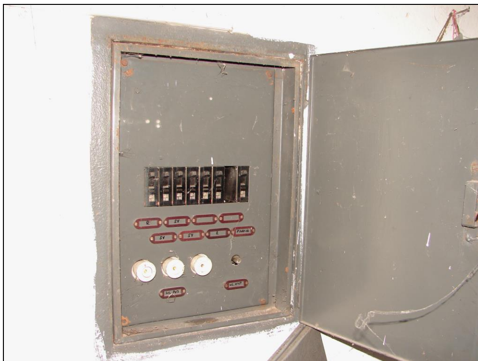
Foto 251: SO 03-55-01, trafostanice, interiér, rozvodna NN; kovový rozvaděč el. energie
