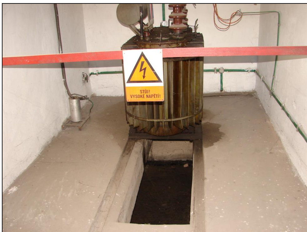
Foto 256 a 257: SO 03-55-01, trafostanice, interiér, transformátor; omítnuté zděné stěny a ŽB strop, betonová podlaha, v oblasti transformátoru je patrná lokální, povrchové a zcela zanedbatelné zasažení betonu olejovými produkty
