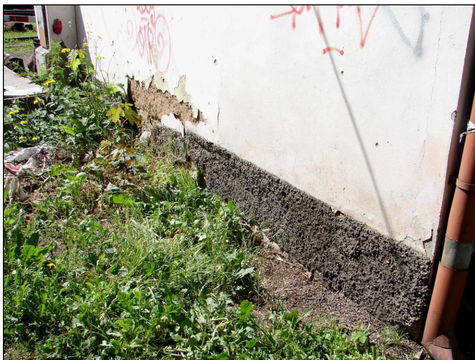
Foto 200: SO 03-55-01, domek TO, pravá fasáda domku při pohledu od trati; omítnutá montovaná panelová konstrukce (foto 201 a 202)
