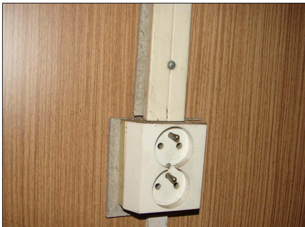
Foto 186 a 187: SO 03-55-01, stavební buňka, demolice č. 9, interiér; pod plastovými lištami s el. rozvody a zásuvkou jsou desky na bázi cementu, (nahore detail z foto 185)
