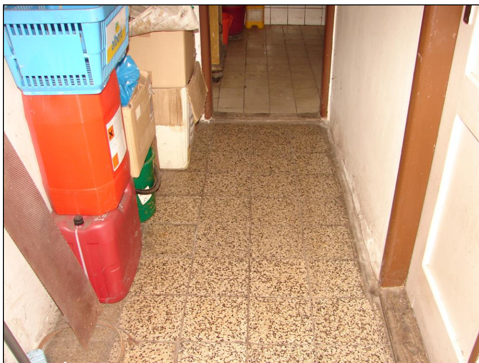
Foto 210 a 211: SO 03-55-01, domek TO, interiér, chodba 2 (foto 203); omítnutý strop a stěny z panelů, el. rozvody na kovových lištách, na betonové podlaze keramická dlažba
