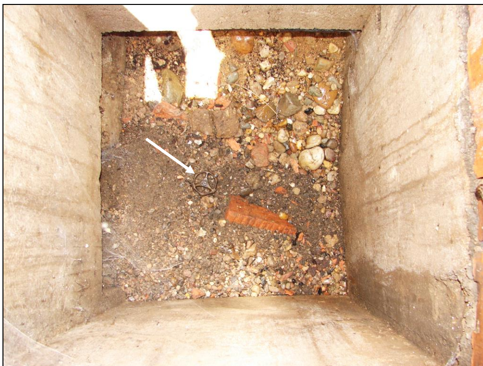
Foto 36: SO 02-55-01, hradlo Barrandov, okolí hradla; poklop z foto 35 zakrývá betonovou šachtici vodovodní přípojky, na dně šachtice štěrk, ze kterého vystupuje ventil (šipka)
