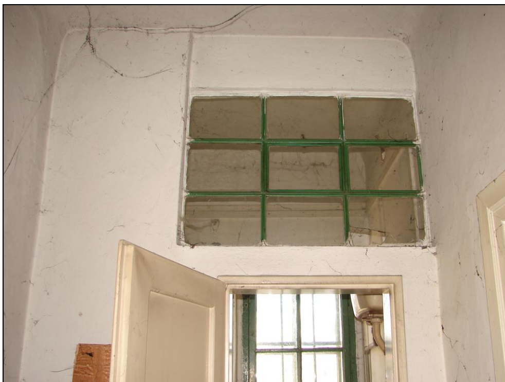
Foto 86: SO 03-55-01, sklad, interiér, předsíň; omítnuté zděné stěny a dřevěný strop, ocelový rastr prosvětlovacího otvoru, vstup na WC
