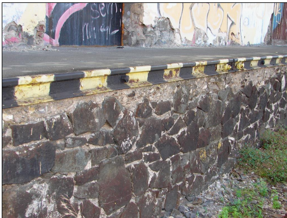
Foto 123 a 124: SO 03-55-01, sklad, rampy; nahoře rampa podél ulice, dole rampa podél trati, kamenné zdivo, na hraně ramp kolejnice, povrch ramp beton, vstup na rampu podél ulice dřevěná šikmá rampa (foto 75), vstup na rampu podél trati betonové schodiště (foto 125)
