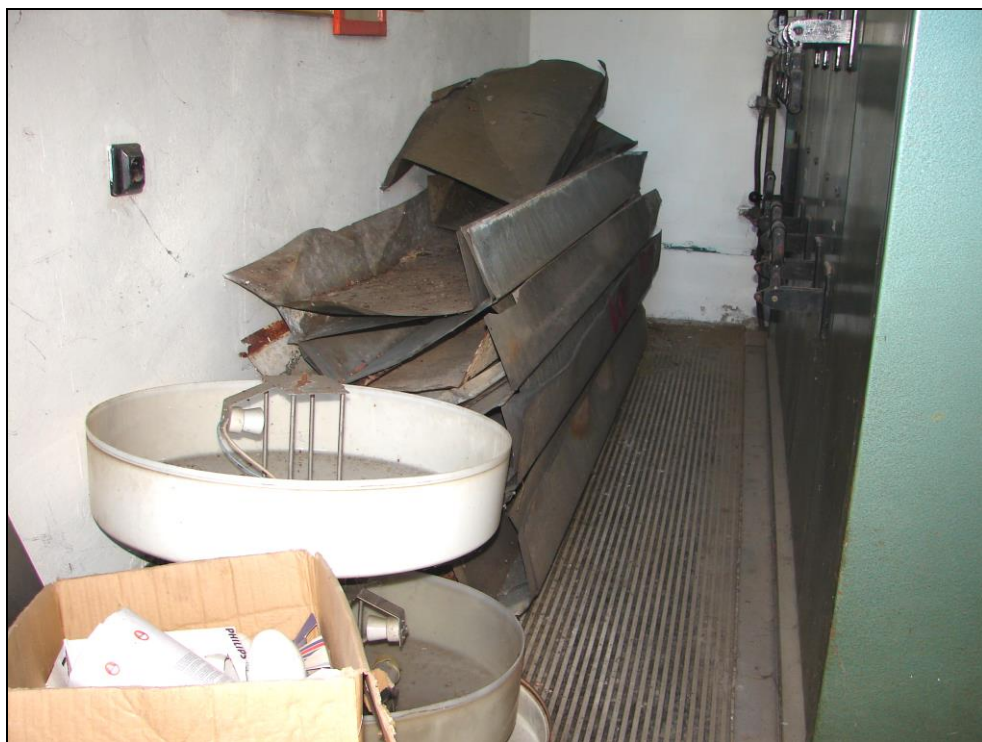
Foto 246 a 247: SO 03-55-01, trafostanice, interiér, rozvodna NN; omítnuté zděné stěny a ŽB strop, prosklení z luxferů (foto 241), na betonové podlaze antistatická pryž
