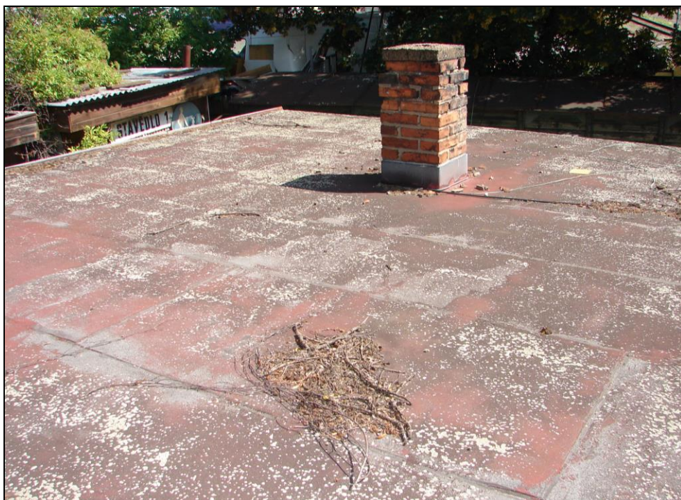
Foto 229: SO 03-55-01, domek TO, střecha; první zděný komín (foto 231), střešní krytina ze souvrství asphaltových lepenek spojených litým asfaltem, z asphaltových lepenek byly odebrány vzorky (foto 236 a 237), asphaltové lepenky neobsahují azbest jako plnivo
