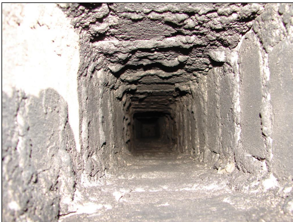
Foto 34: SO 02-55-01, hradlo Barrandov, střecha; zděný komín, pohled do průduchu komínu
